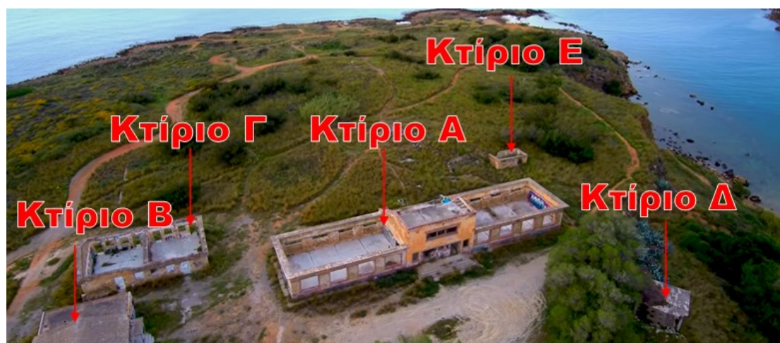
Εικόνα 8 : Υφιστάμενες κτιριακές εγκαταστάσεις
