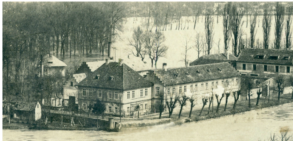
Obr. 9 Brandýs nad Labem – povodeň 1928, limnigraf, budka – kovový kiosek. Druhý nejstarší limnigraf osazený 5. dubna 1901 na pobřežním kamenném pilíři před r. 1870 zrušeného starého dřevěného mostu. Zdroj: Archiv Muzea Brandýs nad Labem.
