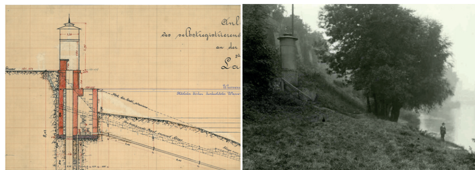
Obr. 10 Louny, Ohře, projekt limnigrafu pro Louny z r. 1901 a fotografie ca z r. 1925 Zdroj: Archiv hydrologické služby ČHMÚ.
