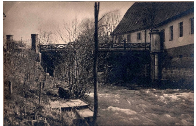
Obr. 14 Limnigraf v Hronově osazený r. 1910, foto dne 23. 4. 1925. Zdroj: Archiv hydrologické služby ČHMÚ.
