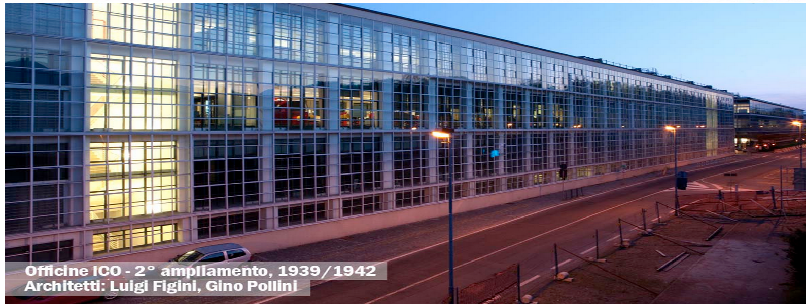
Complesso di costruzioni Olivetti lungo Via Jervis a Ivrea. Dalla prima fabbrica in Mattoni Rossi al primo e secondo ampliamento degli stabilimenti Olivetti I.C.O.)
