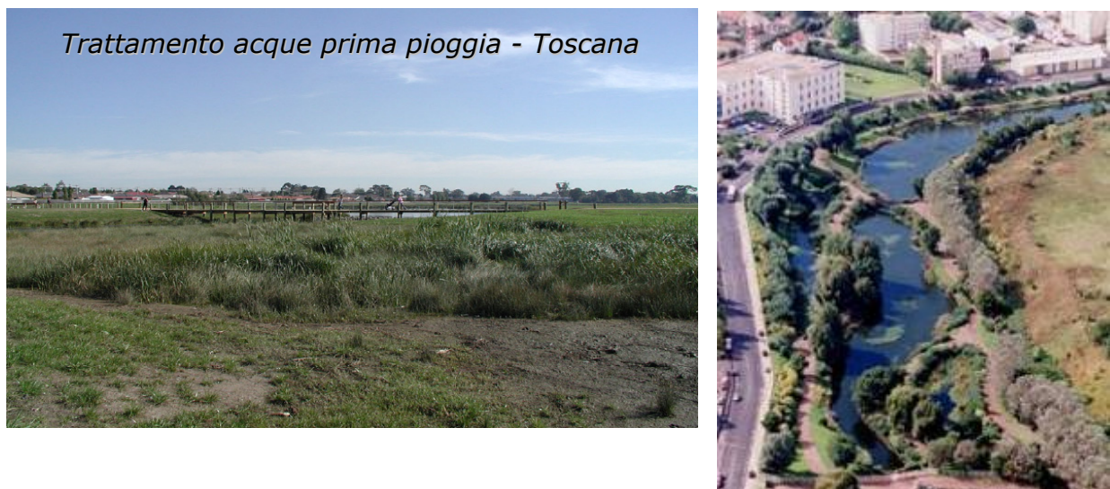
Figura 48 – A sinistra: impianto per il trattamento delle acque di prima pioggia in Toscana. A destra: impianto a flusso sommerso per il trattamento di scolmatori di reti miste (Germania)
