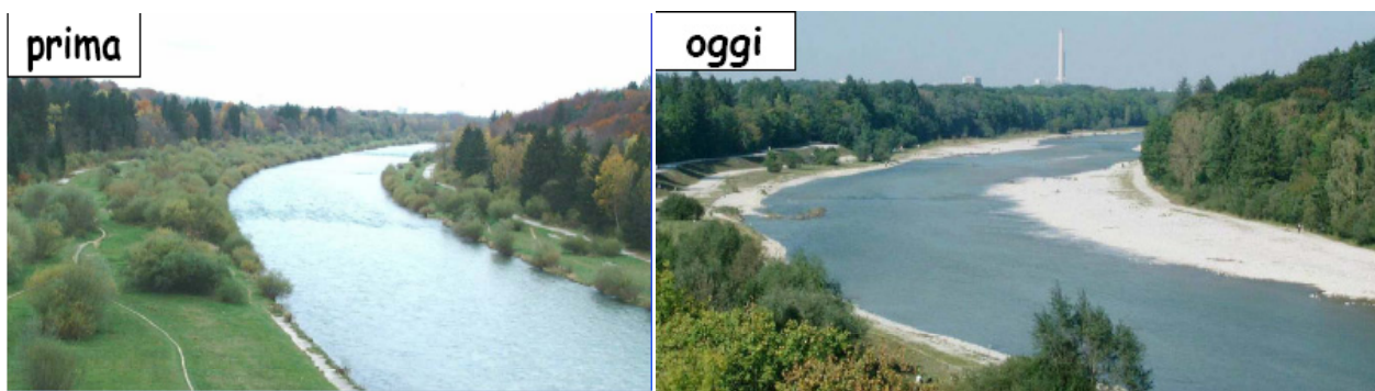
Figura 58 - Fiume Isar a Monaco di Baviera: viene ridato spazio al fiume e favorita la formazione di un tracciato più diversificato e fruibile arretrando le difese. Si noti la neo-formazione di barre interne al meandro.
