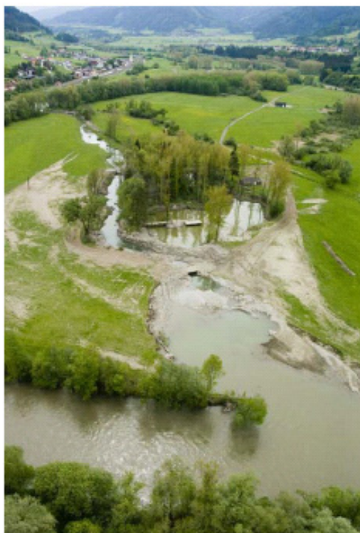
Übersicht der fertig gestellten Maßnahme St.Peterer-Au (nach Hochwasserereignis, Mai 2006)
