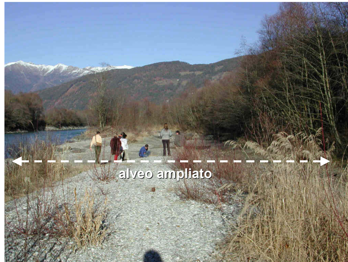
Figura 56 – Ampliamento dell'alveo mediante ricalibratura del canale – Fiume Drava (Austria)
