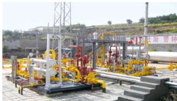
Оборудование проверки коррозии на месте проведения работ для месторождений сернистого газа
