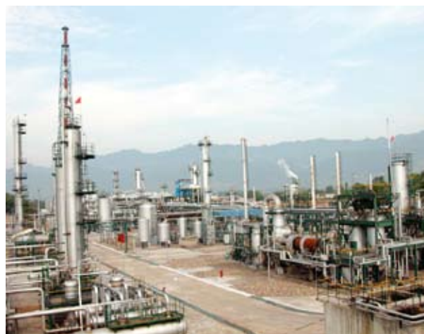
Комплексный очистной завод в г. Чунцин
