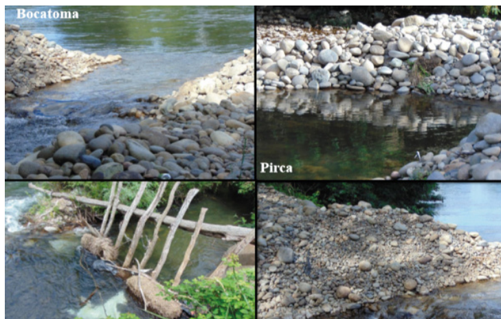
Fotografía de Bocatoma y Pirca en la Región de Ñuble. Fuente: Saldías, J.F. (2019)
