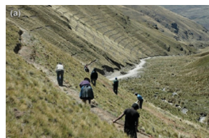
Zanjas de infiltración en Perú: a) Construcción de zanjas. Foto: Comunidad Andina; b) Zanja de infiltración con agua. Foto: Lauren Somers.
