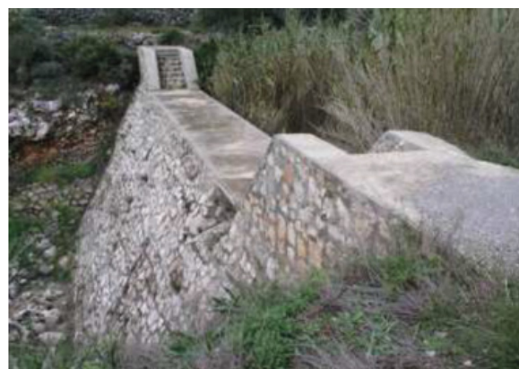
Pared de un tanque de percusión en la provincia de Alicante, España. Fuente: E. Fernández, en MARSOL 2016
