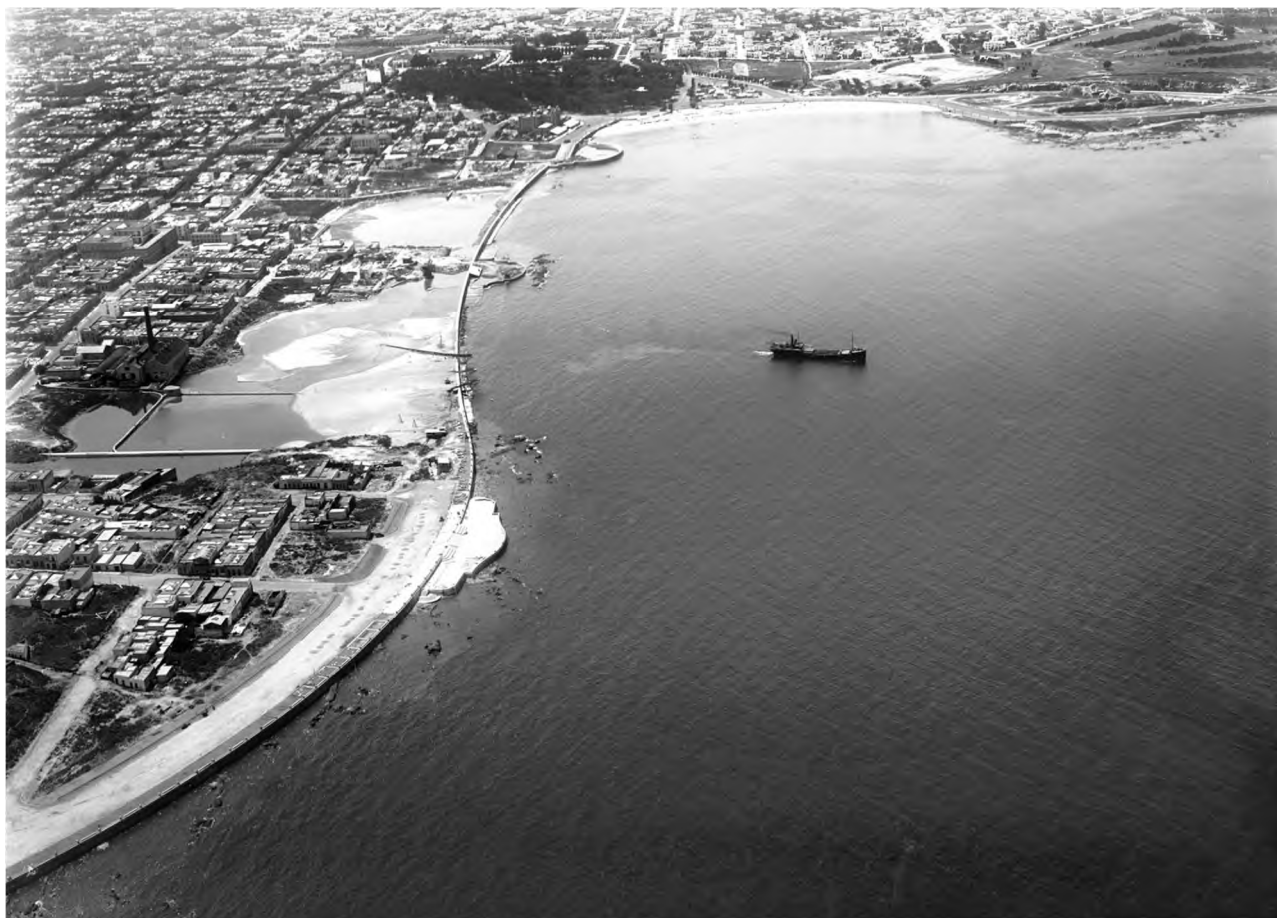
Imagen 4 Vista aérea de las playas de Santa Ana y Patricio durante las obras de drenaje y relleno para la construcción de la Rambla Sur. Año 1930. (Foto: 0174FMHE.CDF.IMO.UY – Autor: S.d/IM).
