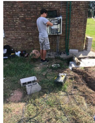
Figura 8: Sistema eléctrico siendo instalado.
