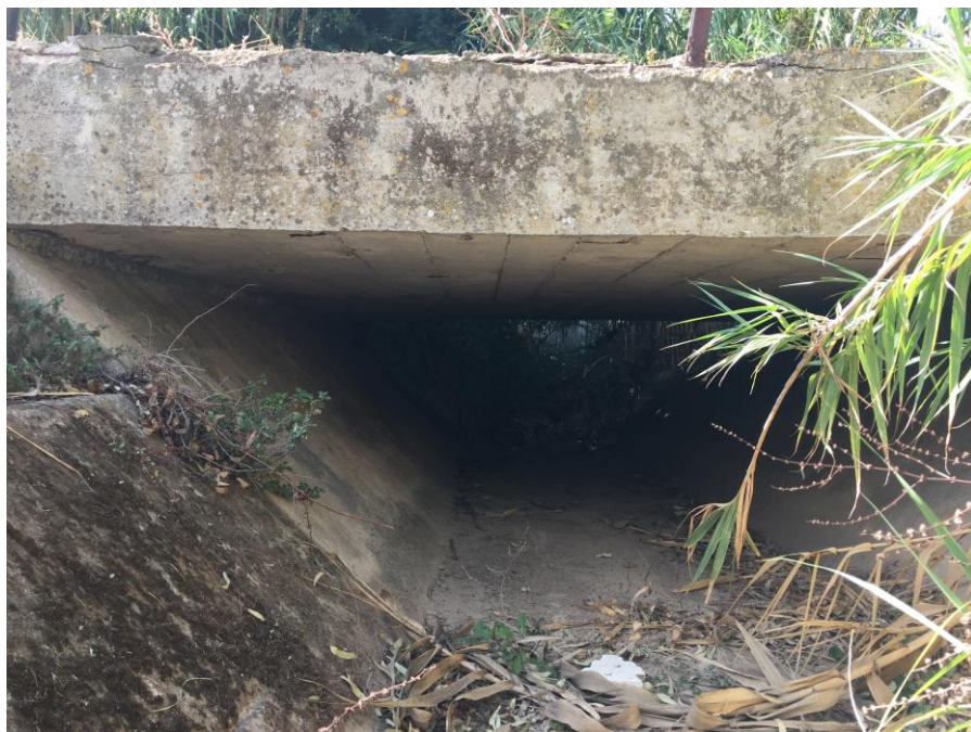
Figura 3 – Canale S.Lucia - tratto iniziale ponte da demolire
