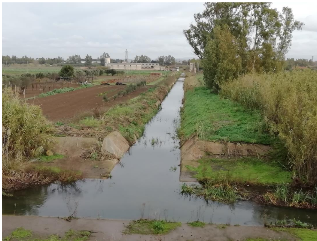
vista sbocco canale S.Lucia su colatore laterale stato attuale
