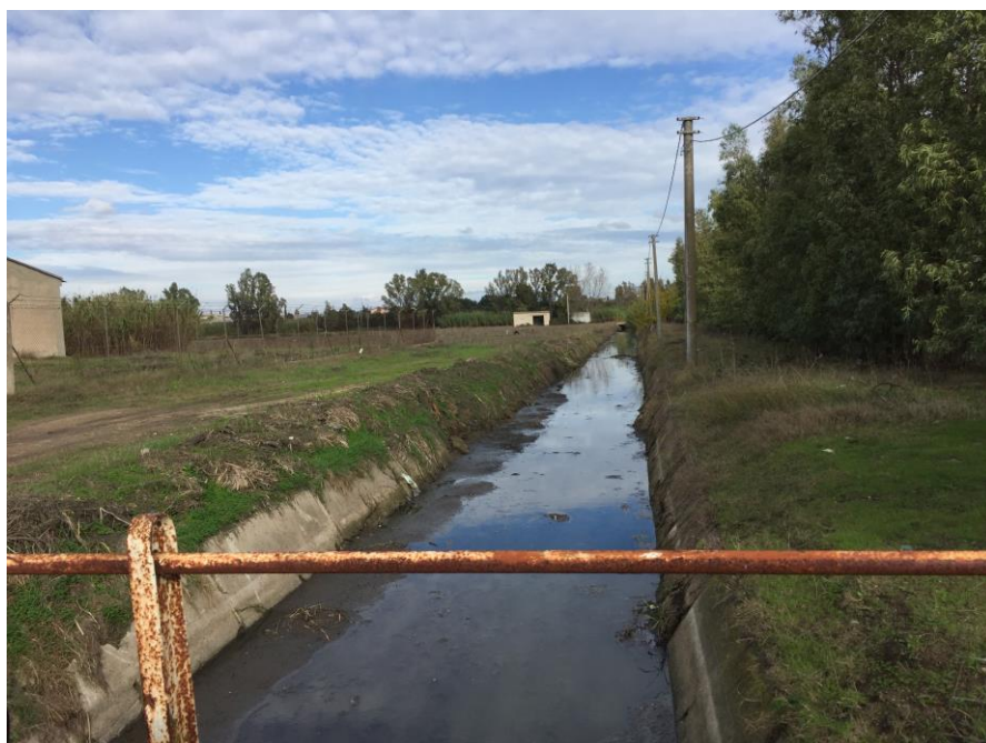
Figura 8 – Canale S.Lucia - tratto tra ferrovia e ponte sulla via Olimpia
