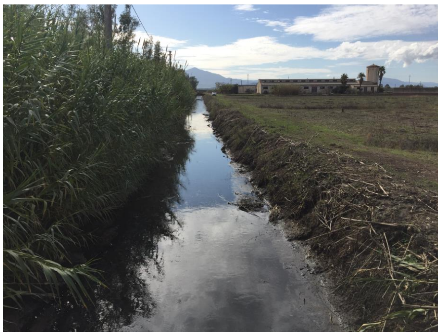
Figura 5 – Canale S.Lucia - tratto iniziale
