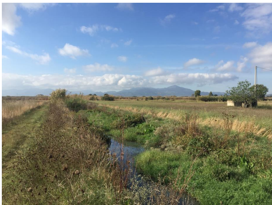
Figura 14 – Canale Gutturu Lorenzu – tratto intermedio
