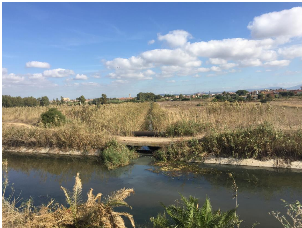
vista sbocco canale Gutturu Lorenzu su colatore laterale stato attuale
