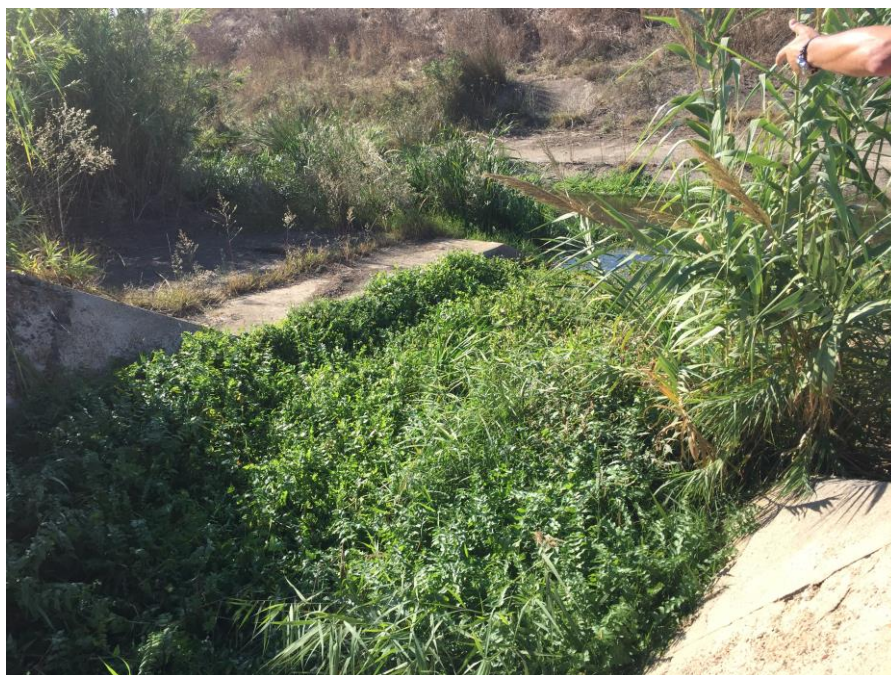
Figura 11 – Canale S.Lucia - Particolare opera di sbocco sul colatore laterale
