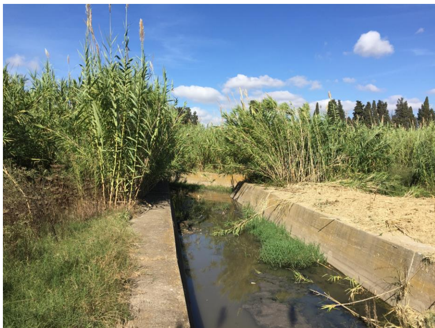
Figura 4 – Canale S.Lucia - confluenza a monte della ferrovia
