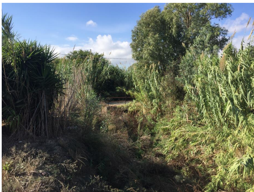
Figura 2 – Canale S.Lucia - tratto iniziale
