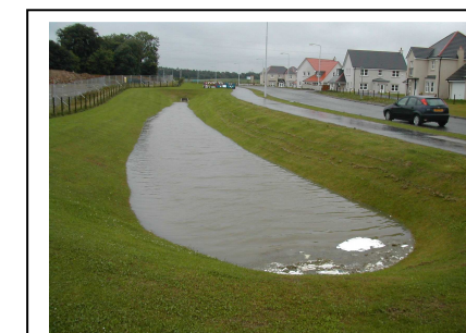
Figura 13: bacino di detenzione
