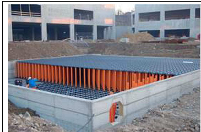
Figura 23 vasca in calcestruzzo in fase di costruzione
