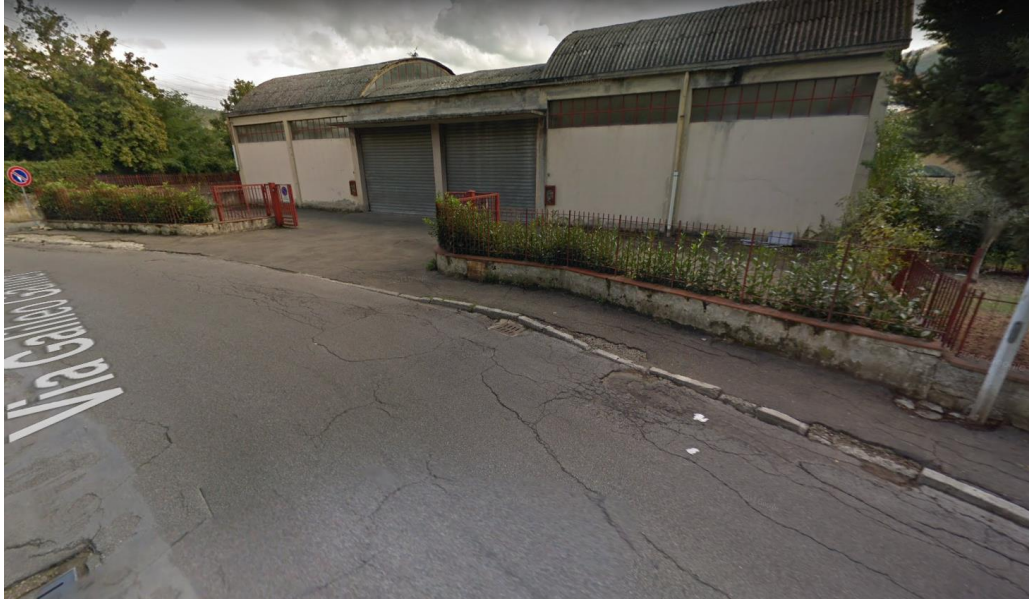
Figura 3-1: Edificio oggetto di Piano Attuativo – Vista da Via Galilei
