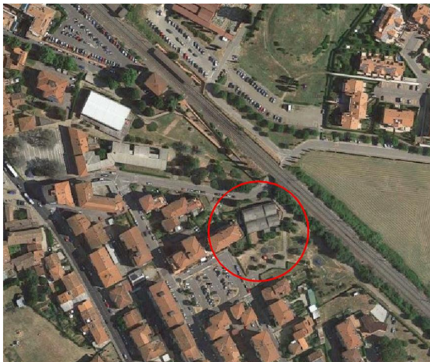
Figura 1-1: Edificio oggetto di Piano Attuativo
