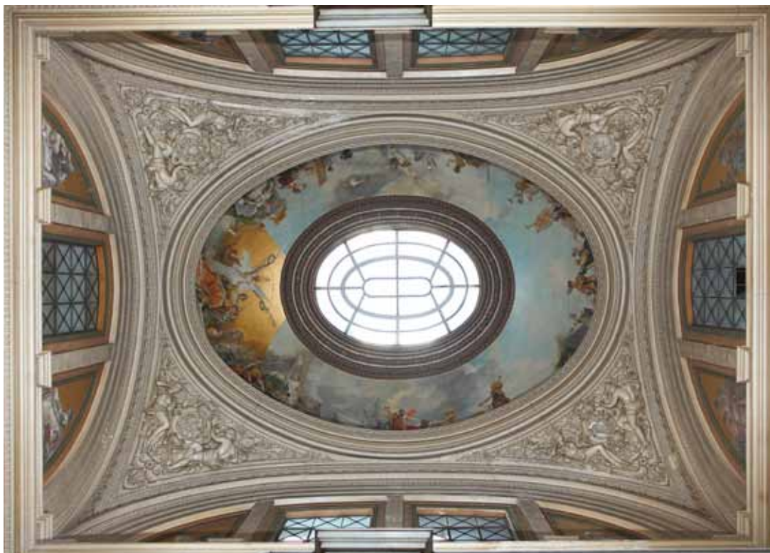
75. Vista de la bóveda de la escalera principal del antiguo Ministerio de Fomento. PL
