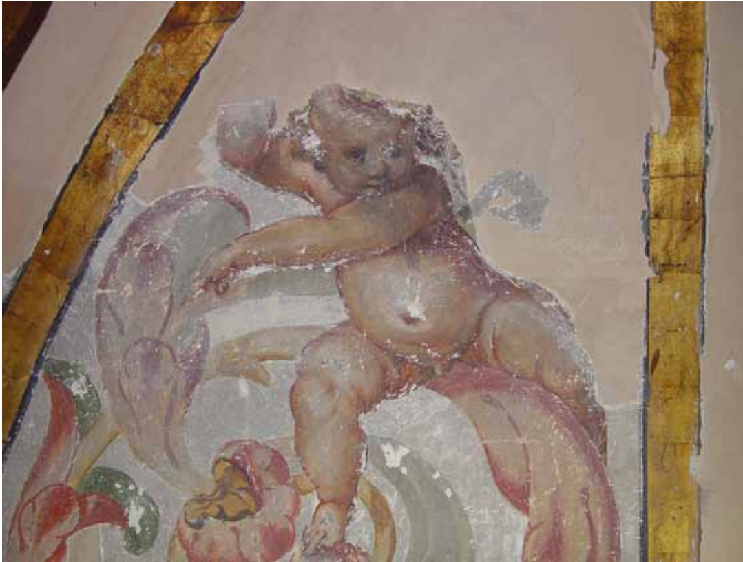
5. La superposición de capas de pintura para adecuar al nuevo gusto o utilidad del edificio es corriente en los paramentos murales. Foto GFG
