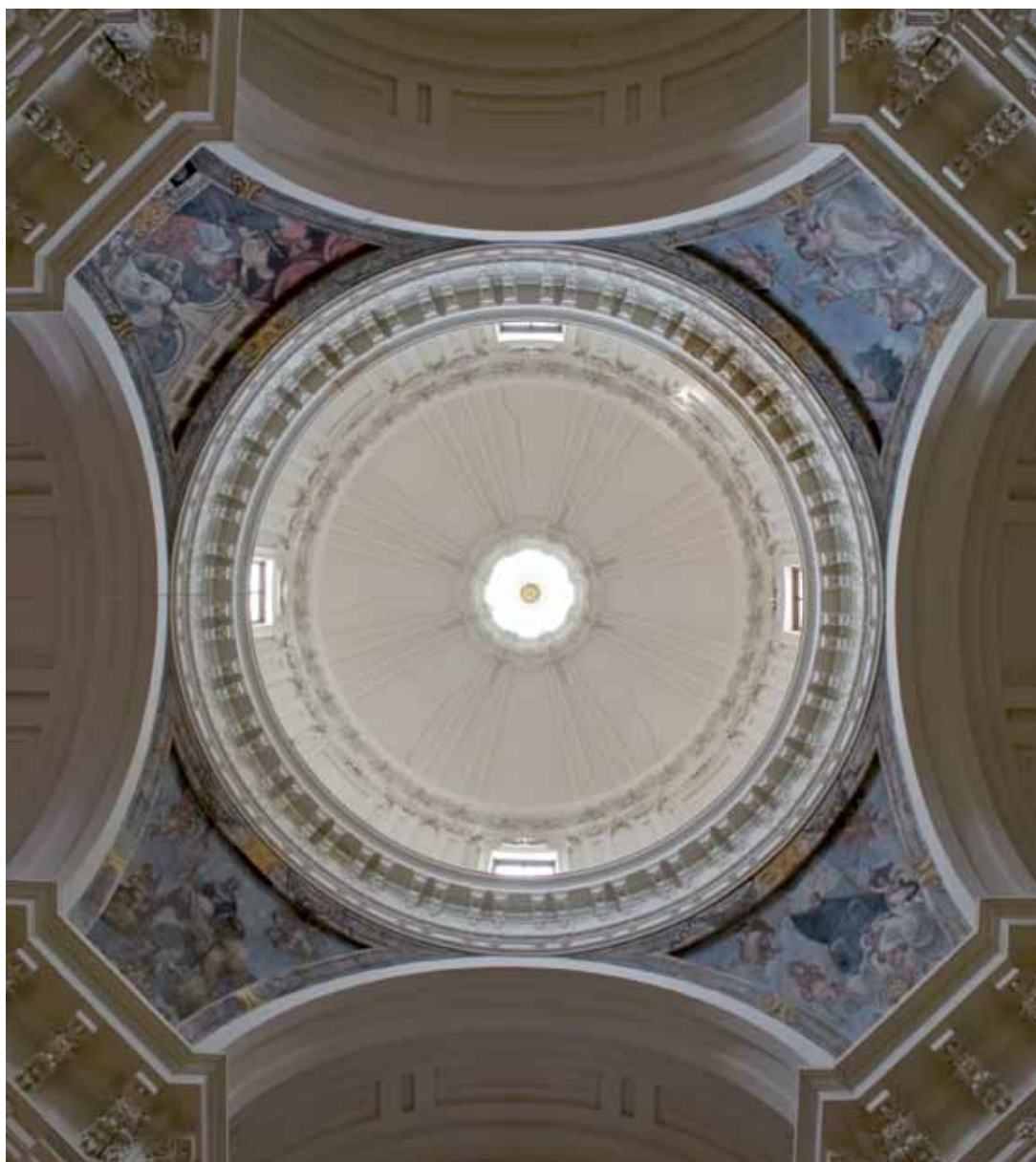
27. Iglesia de las Calatravas (Madrid). Cúpula. Vista General. Foto JCML
