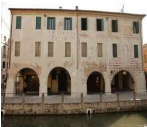
Ristrutturazione edificio residenziale
