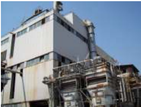
Impianto di conversione "Kaldo" per la produzione di rame raffinato
