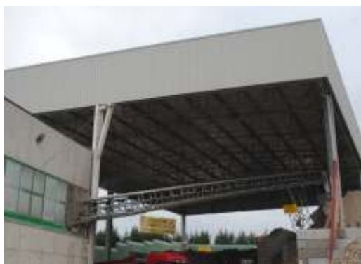
Edificio carpenteria metallica a Noale (Ve)
