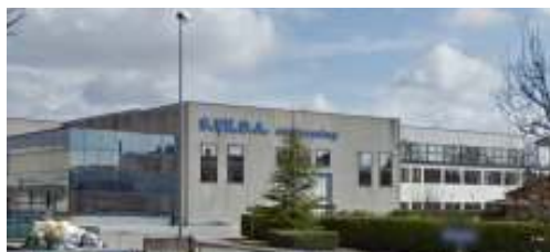
Edificio industriale a Silea (Tv)
