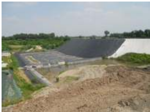
Discarica per rifiuti non pericolosi in comune di Loria (Tv)
