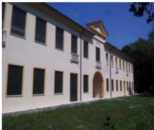
Ristrutturazione a Villorba (Tv) - Progetto e D.L. strutture -
