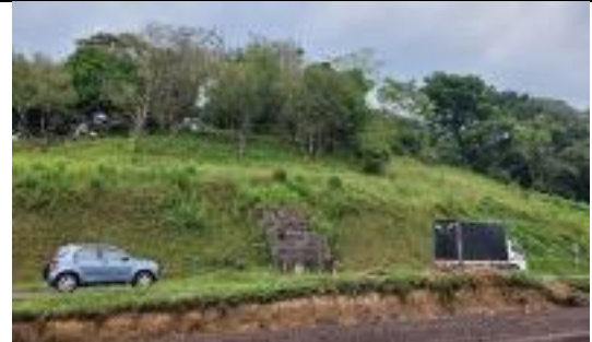
Fotografía 10 Implementación zanja de coronación para Talud 4.1.
