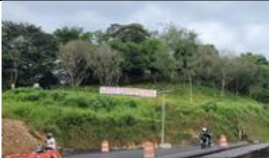
Fotografía 9 Implementación zanja de coronación para Talud 3.1.
