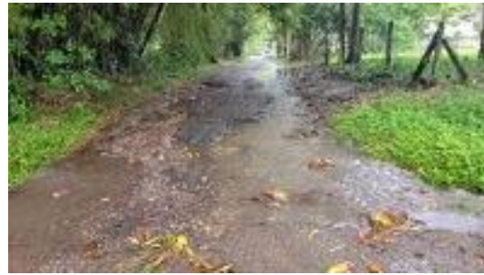
Fotografía 18 Acceso a la vereda Vanguardia Alta, zona inundable por baja capacidad de las estructuras hidráulicas para manejo de aguas lluvias (K5+100)
