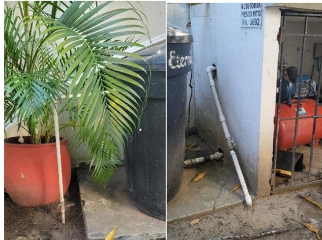
**Figura No.2 Control de ingreso y salida de agua del sistema tanque-motobomba ubicado en el patio-comedor de la sede principal**
