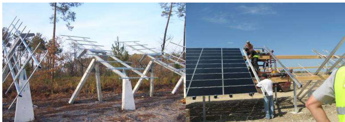
Figure 20 : Montage du support (à gauche), montage module (à droite)
