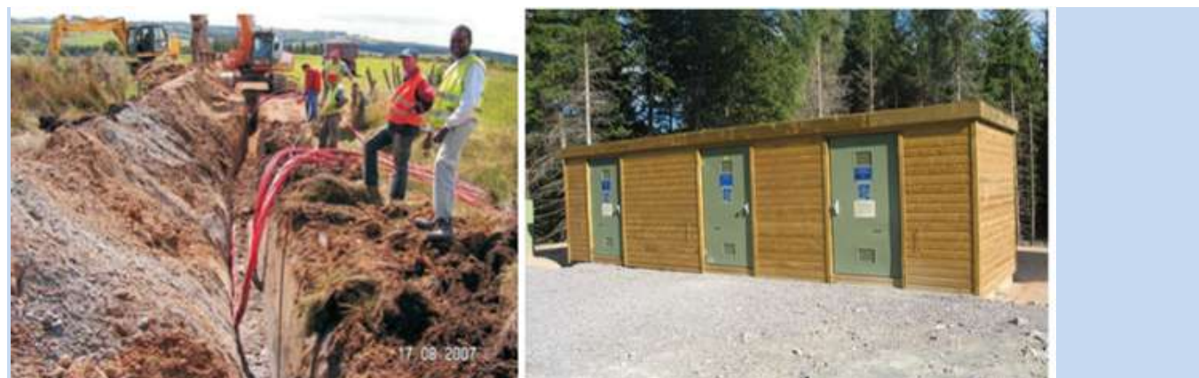
Figure 21 : Déroulage et pose des câbles (à gauche), poste de livraison (à droite)
