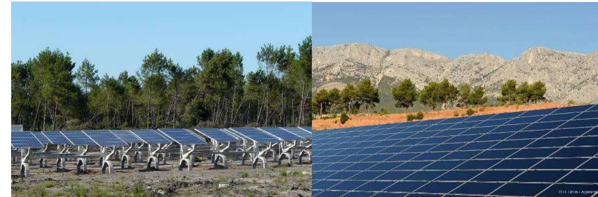
Figure 9 : Structures solaires (à gauche : les trackers de la centrale de Gabardan (40) qui suivent le soleil ; à droite : structures fixes à Puylobier (13)) - Source : EDF EN
