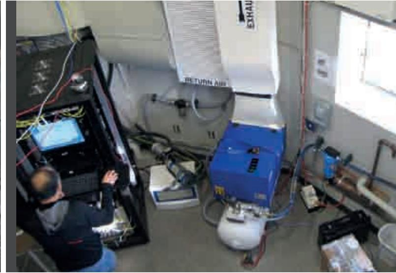
الصورة العليا: تركيب نظام الحماية من التّمور الكهربائي الناشئ عن البرق في محطة رصد النويدات المشعة RN13، أديا، الكاميرون.
