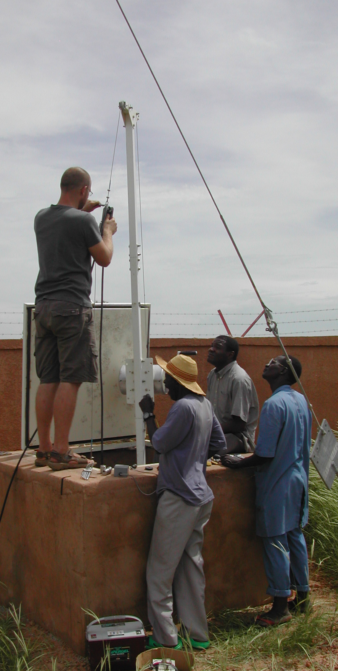
مشروع لإعادة التجهيز في المحطة PS26
