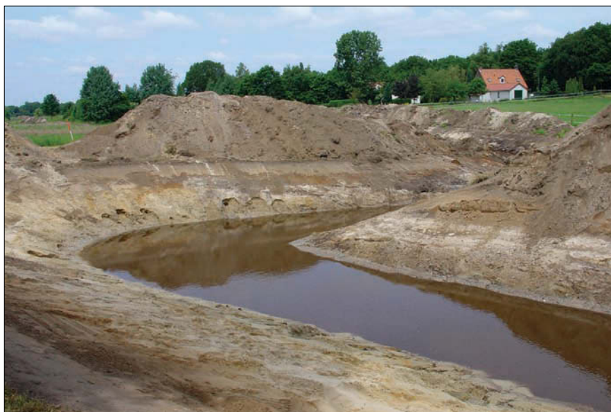
Afb. 3 Dumpzones uit de Romeinse tijd zijn als donkere verkleuringen zichtbaar in het nieuw uitgegraven talud van de Eckeltsebeek, niet ver van de Romeinse villa van Afferden (foto: RACM).
