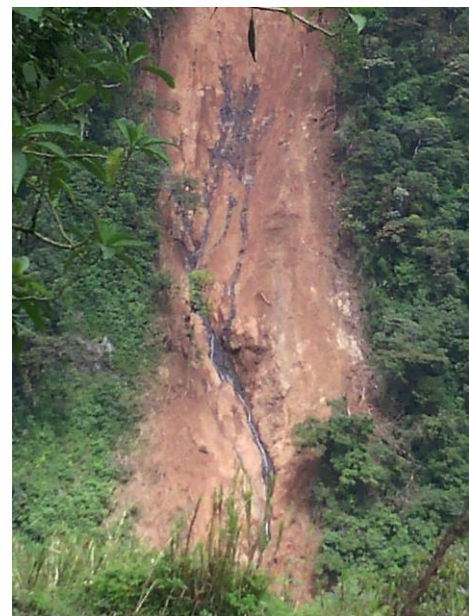
Figura 15. Fenómeno de remoción en masa típico de invierno en añ corregimiento de Río bravo
