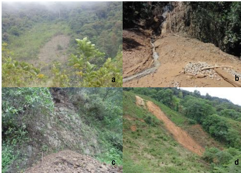
Figura 83. Derrumbes observados en la RFPR de Rióbravo en el Alto y Bajo Calima. a) Derrumbe sector La Piedra, b) Derrumbe entre quebrada el Cuzumbo y La Cristalina, c) Derrumbe en carretera El Muro – Campo Alegre y d) Derrumbe en el sector de Chancos. Foto: Luz Ángela Flórez-Jaramillo.
