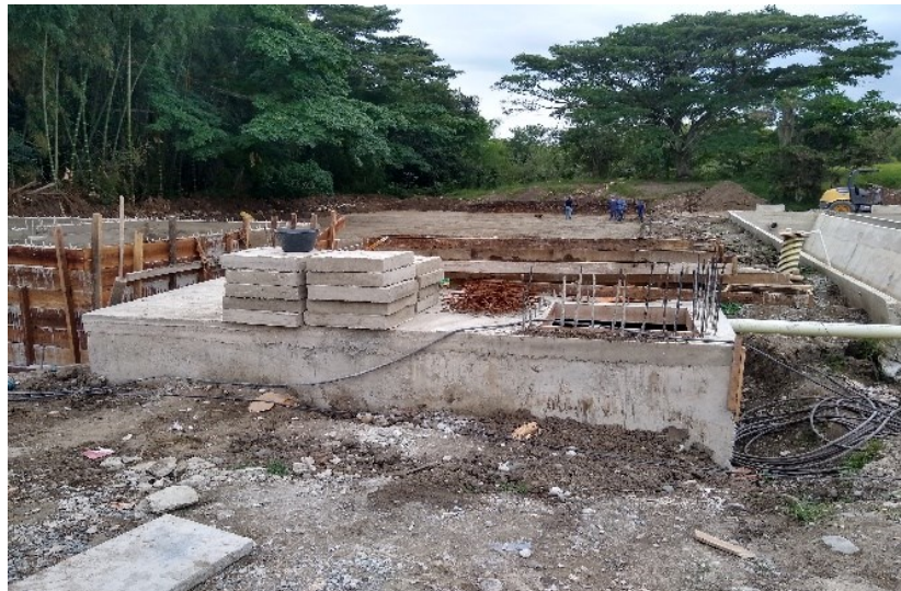
Foto 5 – Tanque de recirculación y FAFA lado izquierdo
