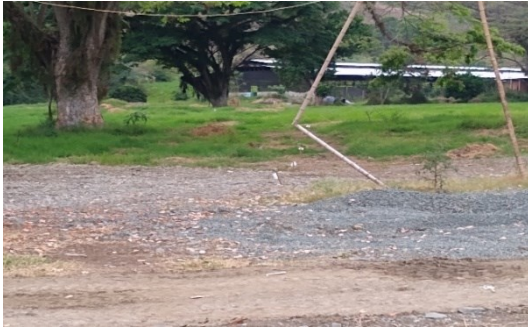
Foto 1 – Trazado tubería afluente tanque de
