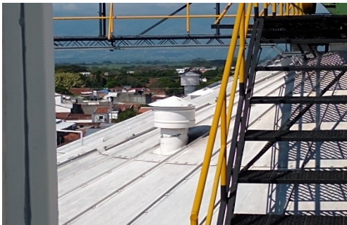
Foto 1. Cubierta ducto salida filtros
