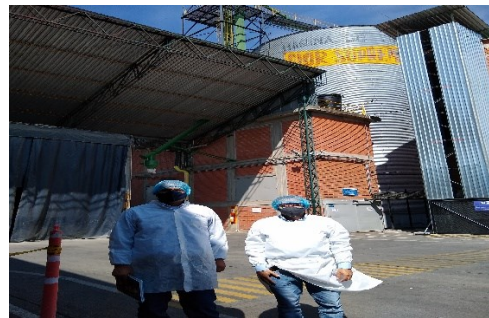
Foto 10. Silo producto elaborado
