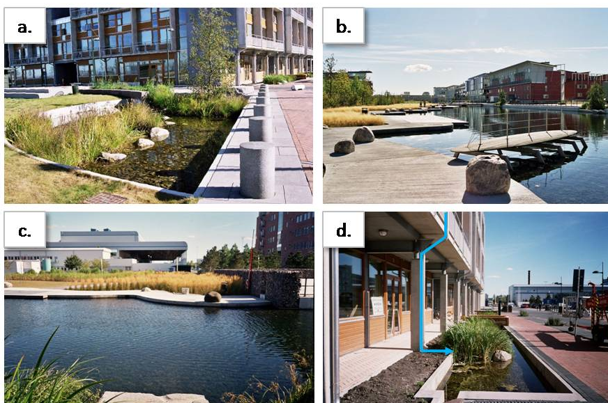
Fot. 32. Urządzenia zrównoważonego systemu drenażu na osiedlu Bo01: a – mały zbiornik retencyjny; b-c – staw retencyjny; d – zbiornik retencyjny zbierający wodę z dachu (fot. A. Drapella-Hermansdorfer)
