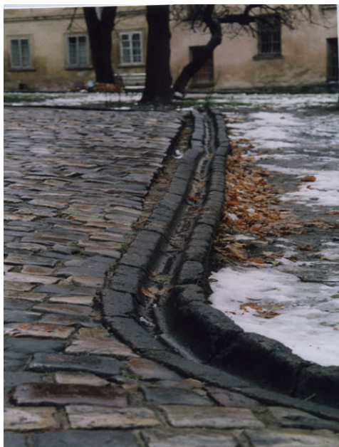
Fot. 13. Typowy rynsztok wykonany z bruku, Lwów (fot. E. Kozłowska) Phot. 13. Typical gutter constructed from stones, Lviv
