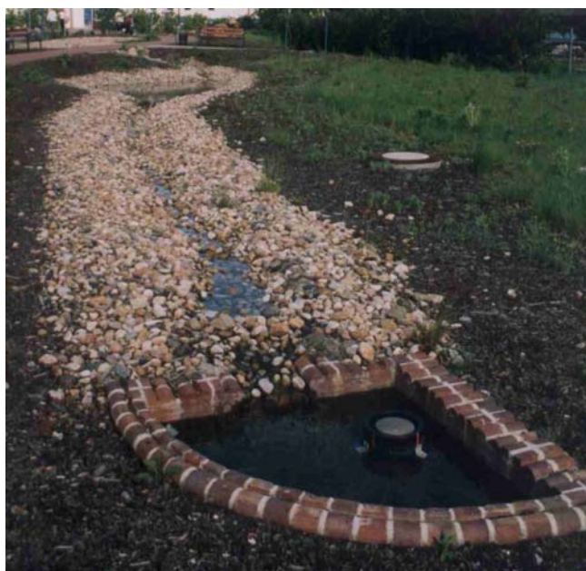
Fot. 17. Suchy potok odprowadzający wodę do miejsca retencji, Krauschwitz (fot. E. Kozłowska) Phot. 17. Dry stone stream carrying water to the place of retention, Krauschwitz
