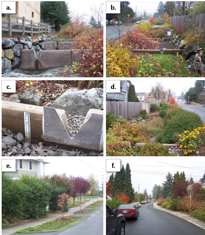
Fot. 24 a, b, c, d, e, f. Przykładowe rozwiązania Natural Drainage System w ciągu komunikacyjnym, Seattle (fot. R. Szcześniak) Phot. 24. Model solutions for the Natural Drainage System in Seattle
