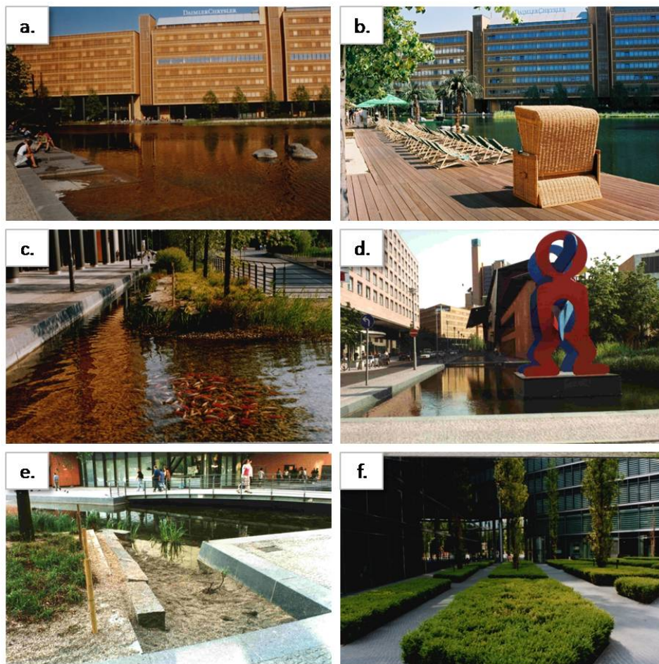
Fot. 27. Plac Poczdamski: a – staw retencyjny; b – miejska plaża nad stawem; c – ryby w stawie; d – rzeźba w kanale wodnym; e – przelew dla nadmiaru wody; f – zwiększanie udziału powierzchni retencyjnej na placu (fot. a, c, d, e, f – E. Kozłowska; b – A. Drapella-Hermansdorfer) Phot. 27. Potsdam Square: a – retention pond; b – urban beach on the pond; c – fish in the pond; d – sculpture in the water channel; e – overflow for high level of water; f – increasing of participation of retention area on the square
