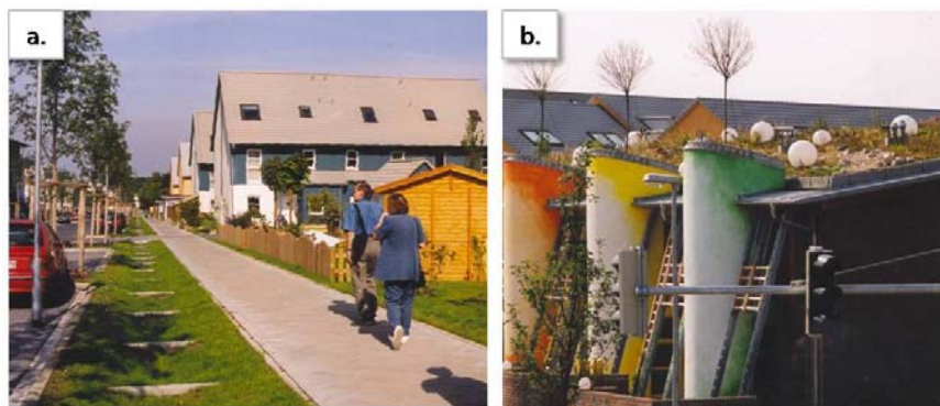
Fot. 29. Urządzenia gospodarowania wodą opadową, Kronsberg: a – muldy chłonne; b – zielone dachy (fot. A. Drapella-Hermansdorfer)
