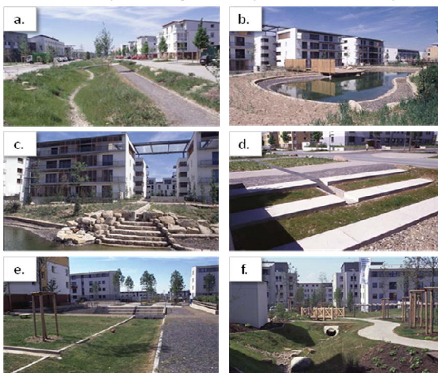
Fot. 30. Urządzenia gospodarowania wodą opadową na osiedlu Kronsberg: a – rów infiltracyjny; b – staw retencyjny; c – kaskadowy dopływ do stawu retencyjnego; d – element odprowadzania wód opadowych; e – mulda chłonna; f – rów infiltracyjny (fot. ze strony: www.oekosiedlungen.de )
