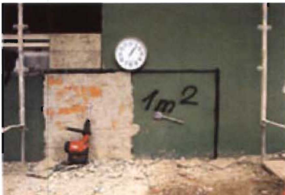
Abbildung 6: Putzabbau mit konventionellem Breitmeißel (Spatmeißel)
