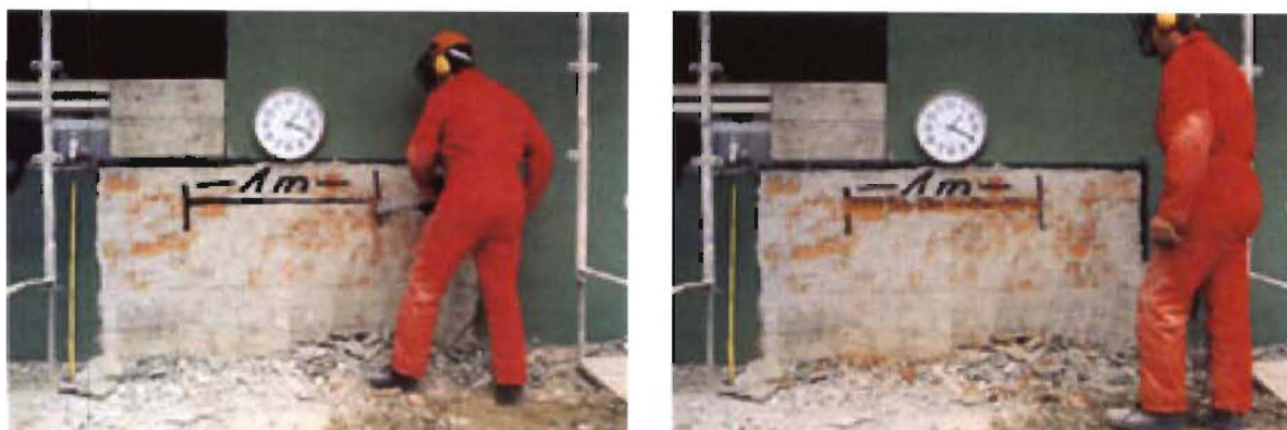
Abbildung 8: Einfräsen eines 1 m langen Schlitzes mit 3 cm Tiefe und 3 cm Breite in nur einer Minute in eine Ziegelwand mit der Meißelkralle
