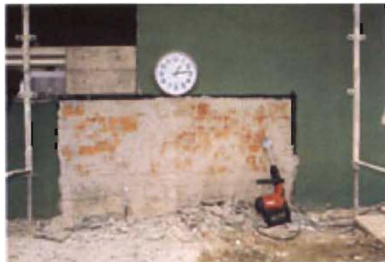
Abbildung 7: Putzabbau mit neuartigem Meißelsystem „Kralle“
