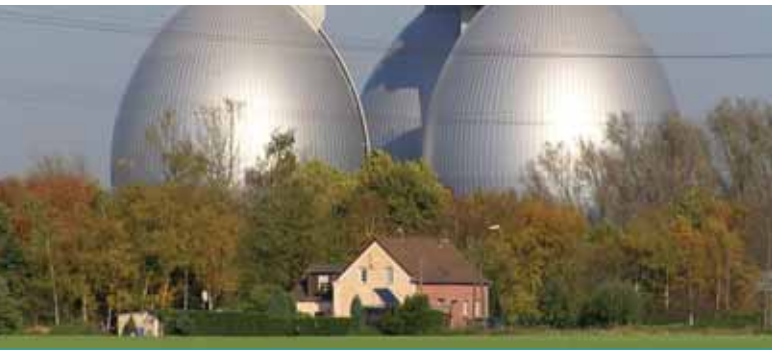
Δεξαμενές αναερόβιας χώνευσης, μονάδα επεξεργασίας λυμάτων «Emschermündung» (Γερμανία)
