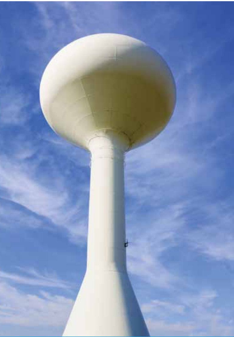
Αποθήκευση πόσιμου νερού σε πύργο νερού
