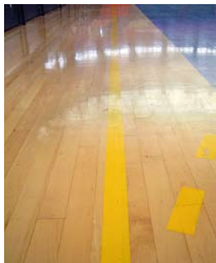
Tarima de madera barnizada.
