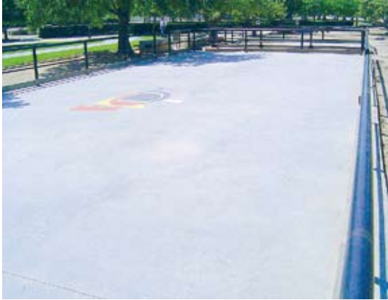
Pista de Patinaje de hormigón con tratamiento endurecedor.
