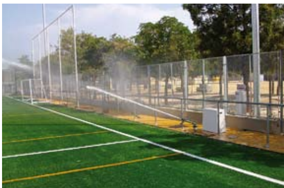
Cañón de riego de alta presión.
