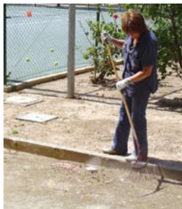
Rastrillado. El rastrillado de los pavimentos de tierra destinado a la regularización de la superficie se puede realizar conjuntamente con la actividad de limpieza. De este modo, las dos operaciones se ejecutarán al mismo tiempo. Tan sólo habrá que tener la precaución de utilizar un rastrillo de jardinería que pueda profundizar un poco más que el rastrillo de púas que aparece en la fotografía.
