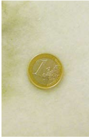
Pavimento de mármol.
