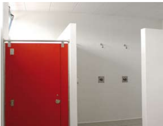
Azulejos 20×20 en vestuario.
