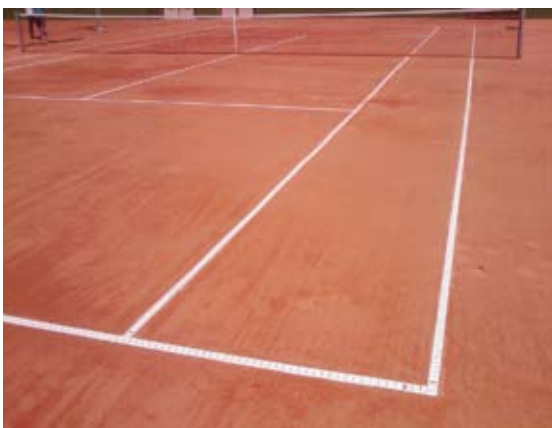
Líneas de Tenis de perfiles prefabricados plásticos.
