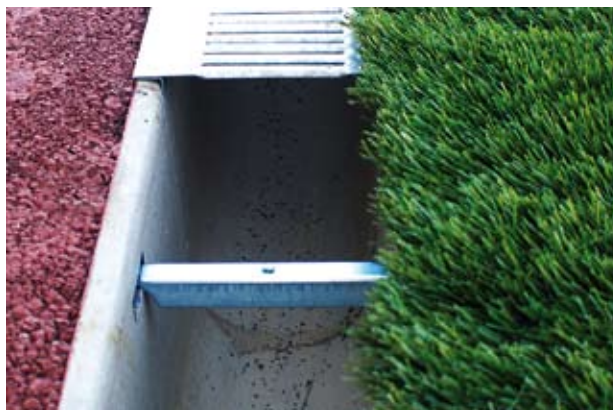
Canala recogida pluviales.
