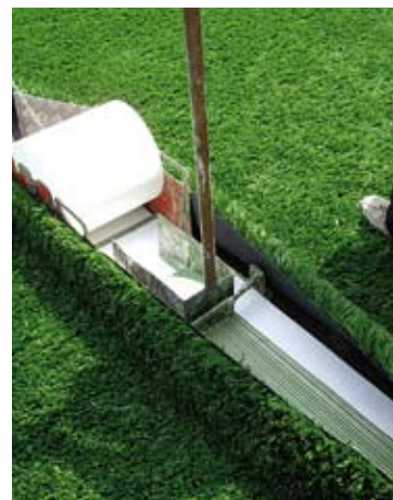
Encolado de junta.
