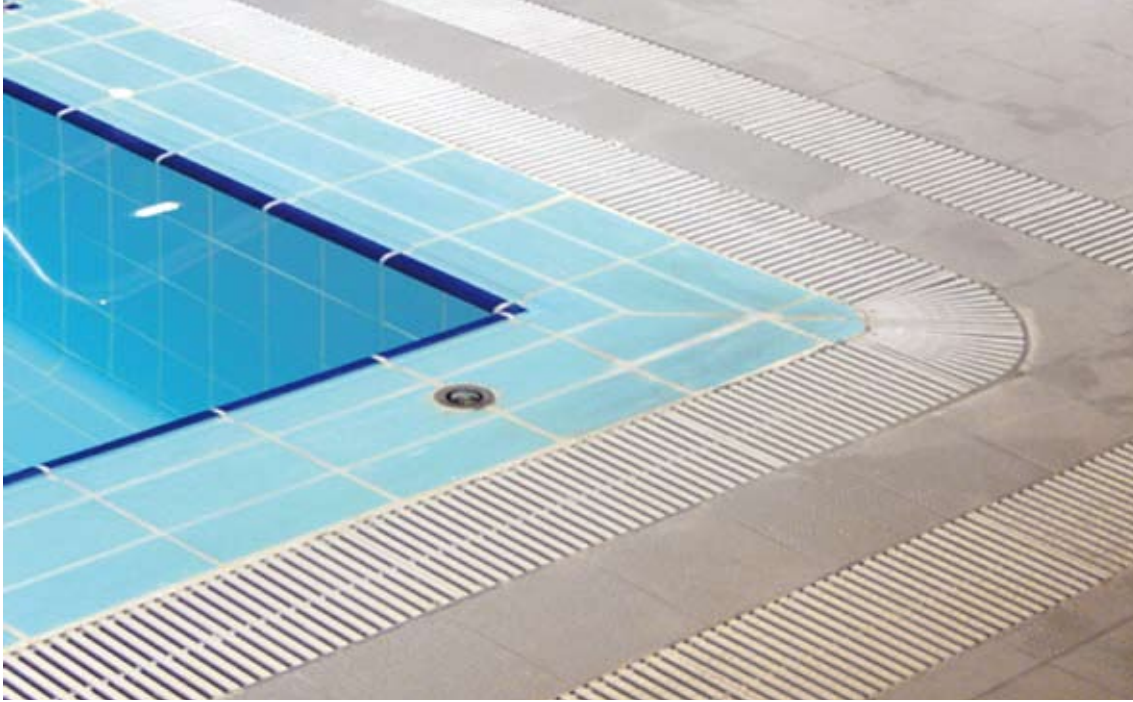
Vaso piscina de hormigón.
