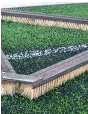
Cepillado con triángulo.
