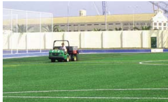
Recebo de caucho con máquina dosificadora.
