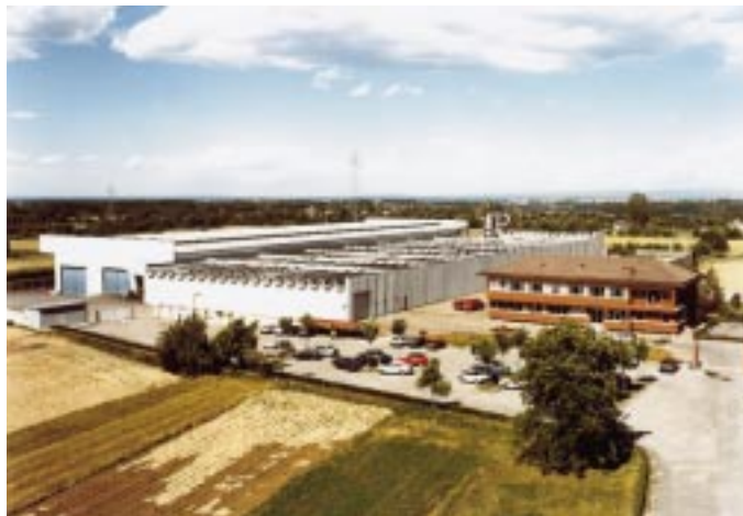
Bild 1 Neu in der Vaillant-Gruppe: Heizkesselhersteller Bongioanni Pensotti Kalore (BPK) in Vignolo bei Turin
