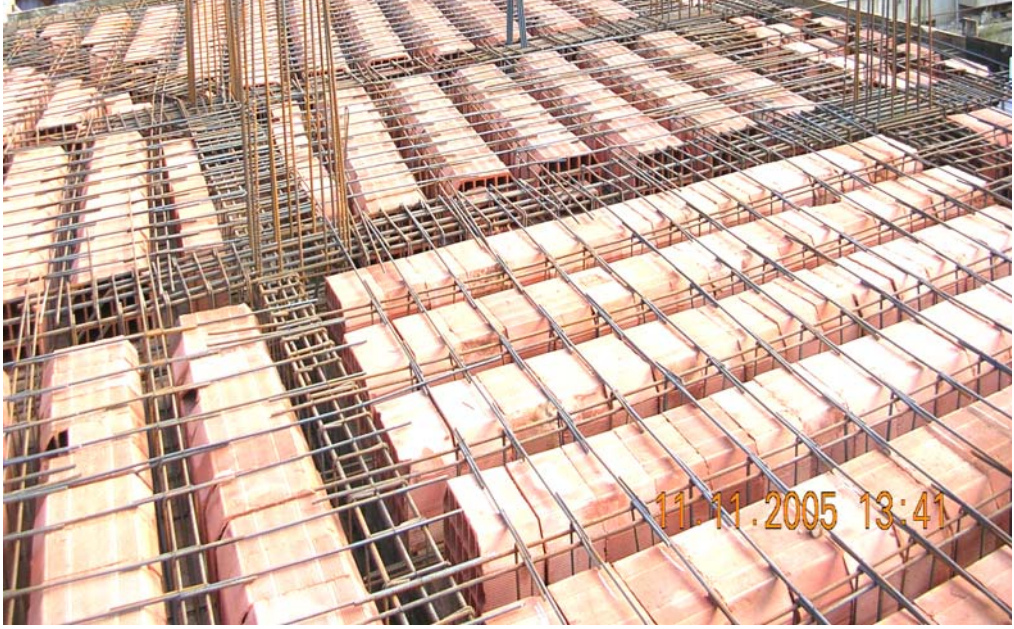
Resim 2.8 Pişirilmiş kil blok döşenmiş döşeme, kolon ve kiriş demir donatı bağlantısı
