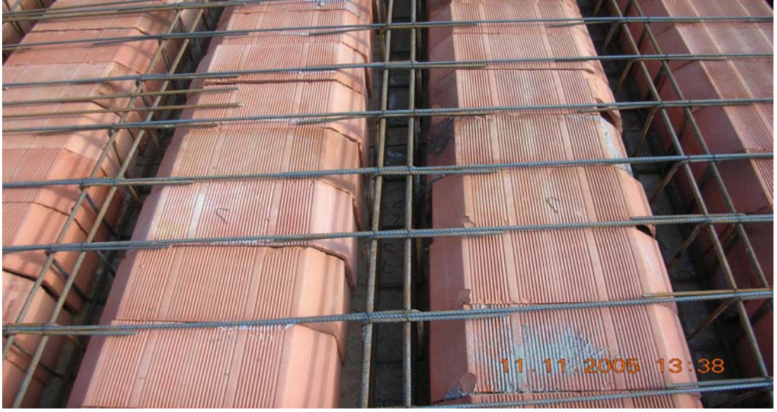
Resim 2.6:Pişirilmiş kil blok donatıya göre döşeme şekli
