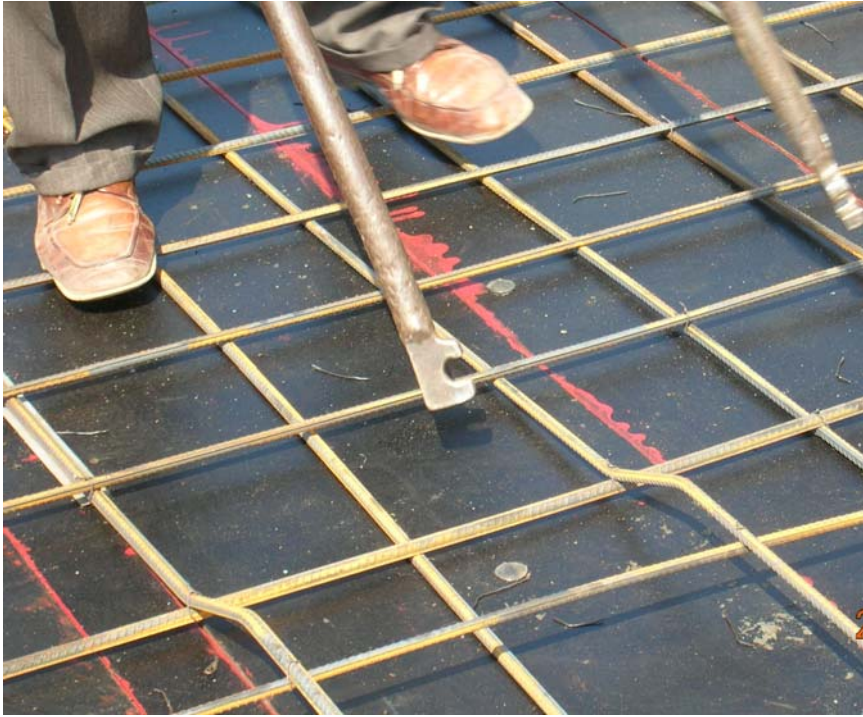
Resim 2.2: Döşemelerde pilye kıvrım ve bağlama şekli
