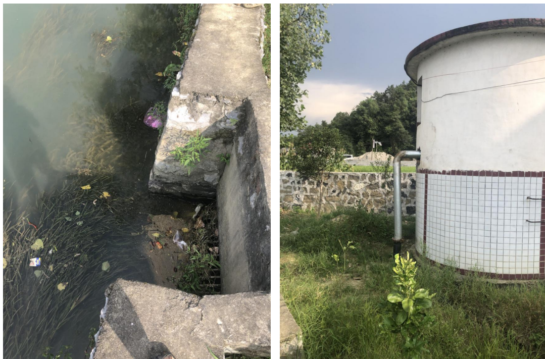
图2-4 水东水厂取水口及蓄水池现场图
