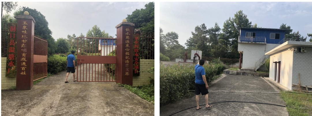
图2-5 温塘水厂现场图
