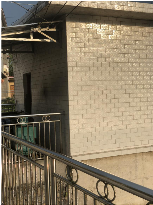
图 2-2 温塘水库取水井现场图
