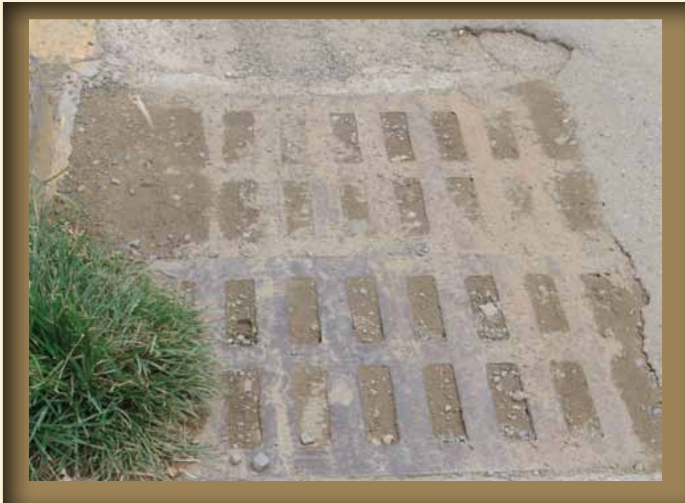
Foto número 6: Alcantarilla pluvial totalmente obstruida en Humacao
