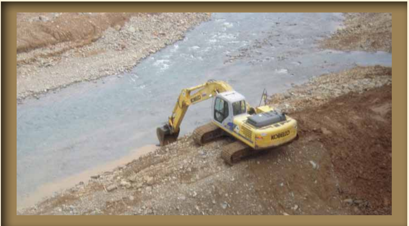
Foto número 21: Trabajos de limpieza en Río Fajardo, sector Paraíso.
