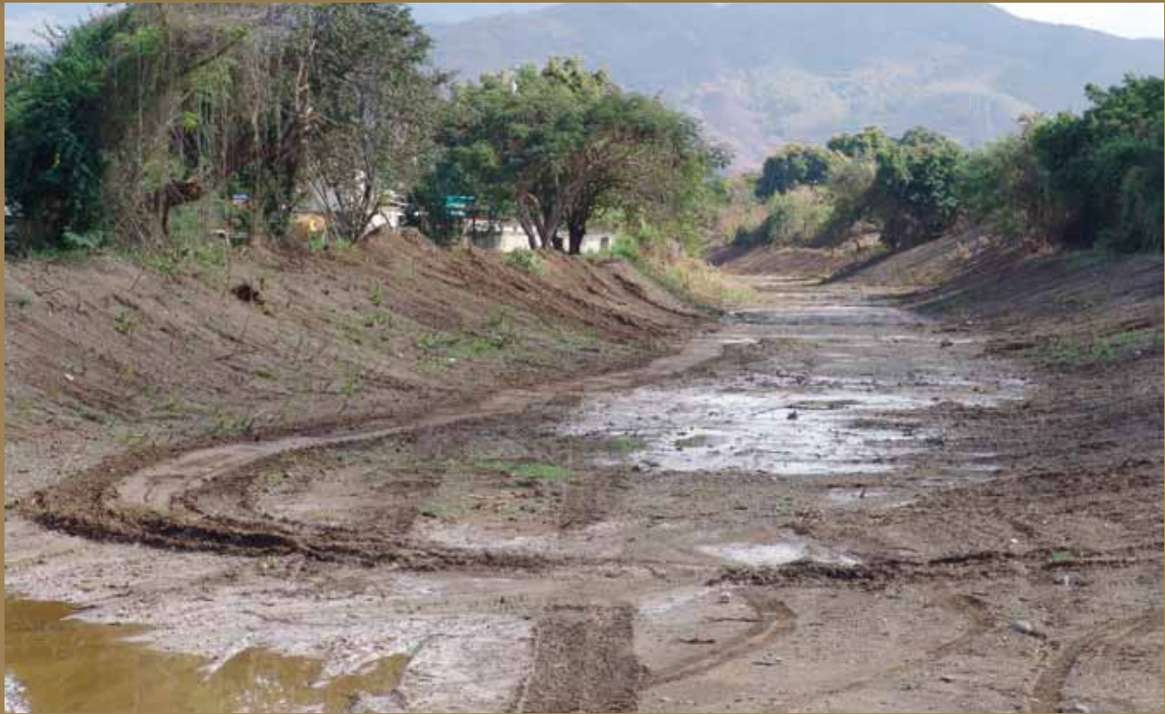
Foto número 19: Canalización de una quebrada en Salinas, Puerto Rico.
