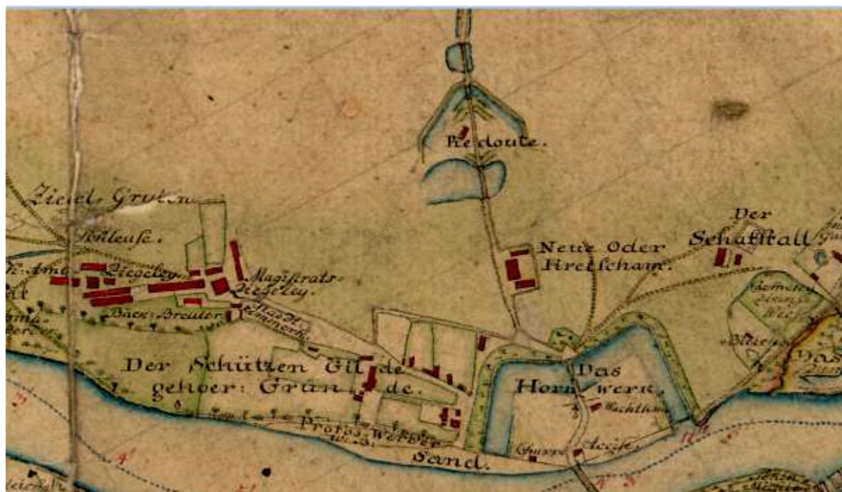
Ryc. 26. Zagospodarowanie prawego brzegu Odry (z fortem rogowym, redutą, siedzibą bractwa kurkowego, ceglarnią miejską) na mapie topograficzno-majątkowej dotyczącej koryta Odry w rejonie Brzegu, z lat 1791-1792 (fragment). W zbiorach Archiwum Państwowego we Wrocławiu, zespół akt: Zarząd Regulacji Rzeki Odry, sygn. I-125
