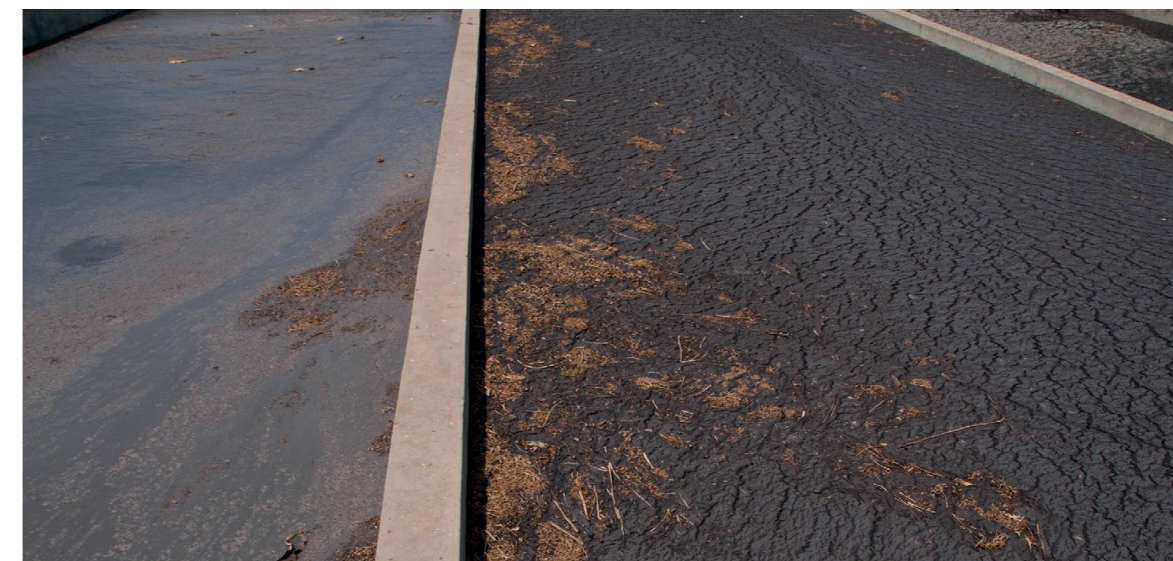
Figura 7.2 Dos lechos de secado sin plantas, uno recién cargado (izq.) y otro parcialmente seco, en la Estación de Tratamiento de Lodos Fecales Niayes, en Dakar, Senegal (foto: Linda Strande).
