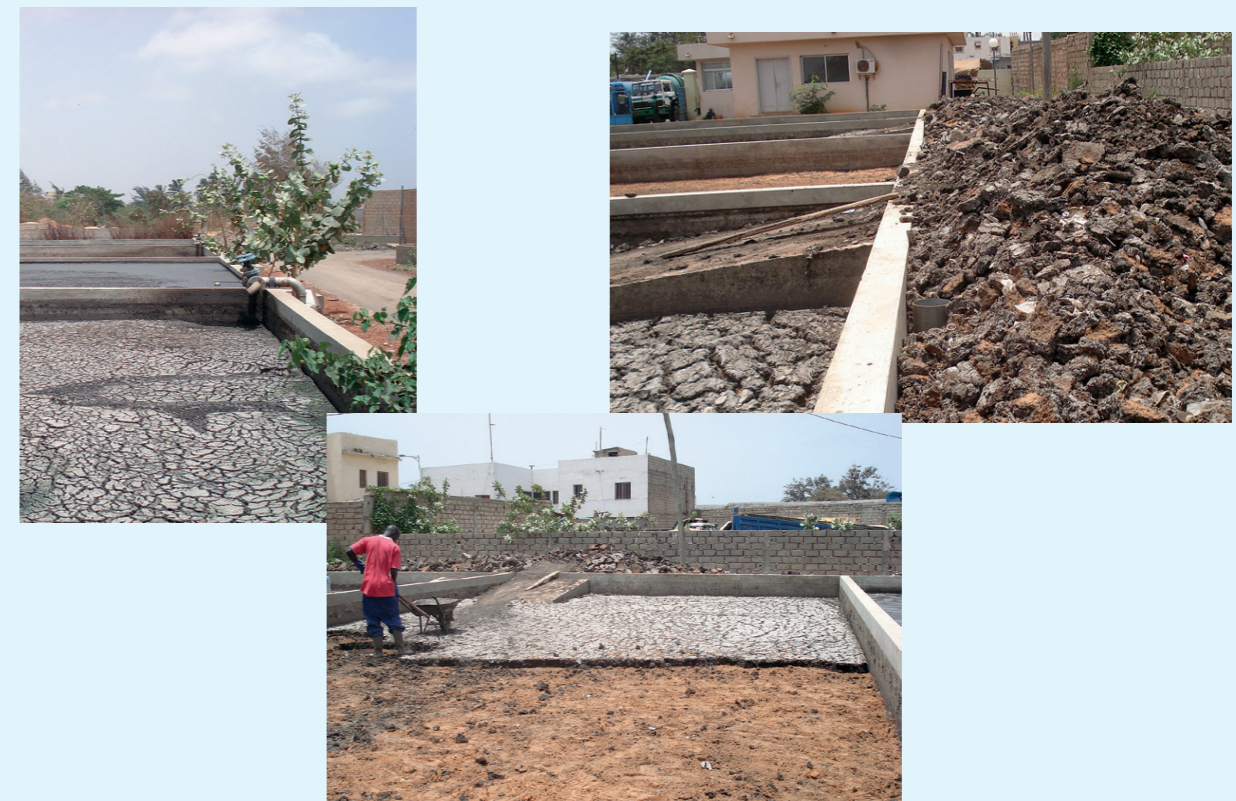
Figura 7.6 Lechos de secado sin plantas, con la acumulación y extracción de los lodos (der.), en la Estación de Tratamiento de Lodos Fecales Cambérène, en Dakar, Senegal (fotos: Pierre-Henri Dodane).
