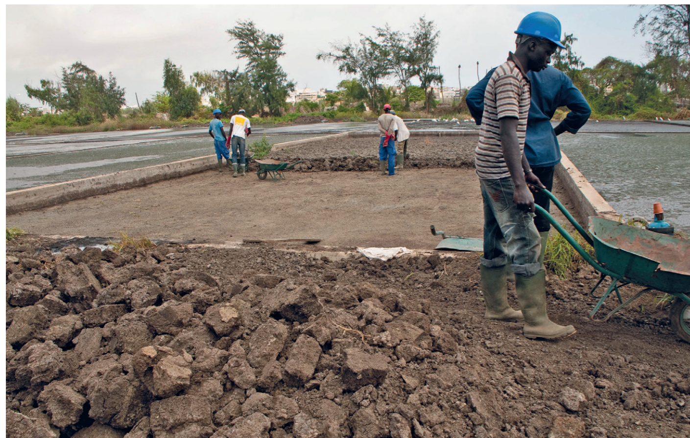
Figura 7.5 Extracción de lodos de los lechos de secado sin plantas en la Estación de Tratamiento de Lodos Fecales Cambérène, en Dakar, Senegal. En primer plano, se observan los lodos ya sacados (foto: Linda Strande).
