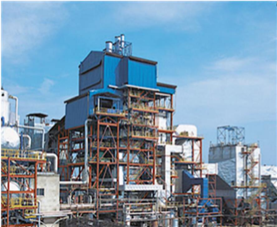
Figura 10.46. Planta de generación eléctrica de 30 MW con co-combustión con carbón, bagazo y cáscara de arroz de Dhampur Sugar Mills en Asmoli, India.
