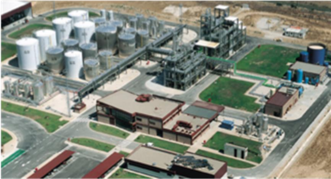
Figura 10.14. Planta de producción de biodiésel de Caparrosa (Navarra, España) a partir de aceites vegetales y que utilizaba un proceso de esterificación.
