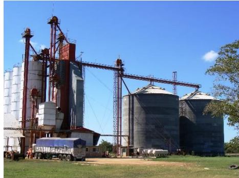
Figura 3.6 Centro de acopio de cereales
