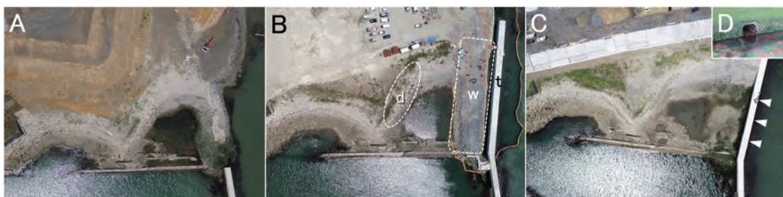
図 2. 松原海岸の空撮写真. A: 2017年5月, B: 2020年6月, C: 2023年5月, D: 導流堤に設置された通水管. d: 震災がれき, w: 導流堤建設工事の際の作業道, t: 導流堤, ◀: 通水管の設置位置.
