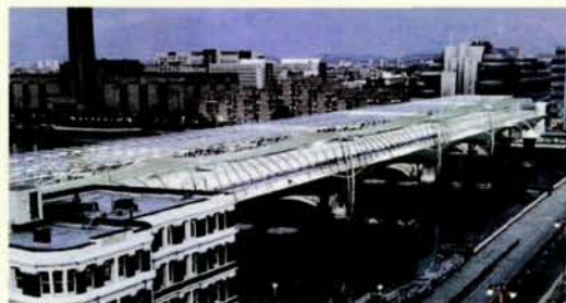
Costruzione di una nuova stazione nel quadro del progetto Thameslink 2000, finanziato nel 1997
