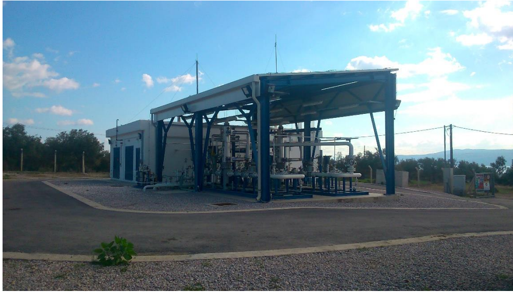
Εικόνα 6-4Τυπικό Κτίριο Σταθμού Μέτρησης
