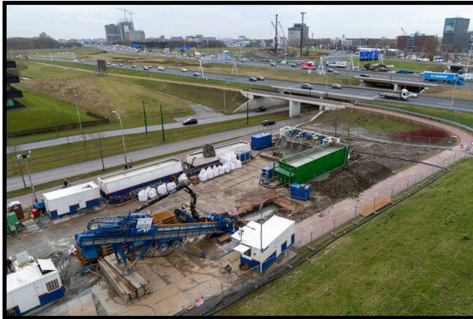
Εικόνα 9-2 Διάταξη εργοταξίου σημείου έναρξης οριζόντιας κατευθυνόμενης διάτρησης
