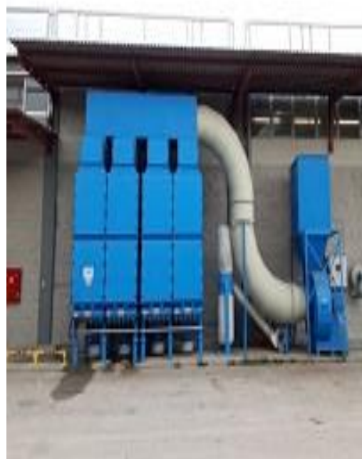
Φωτογραφία 15.8 & 15.9: Άποψη των συστημάτων επεξεργασίας αέρων ρύπων (συστήματα φίλτρων) της μονάδας.
