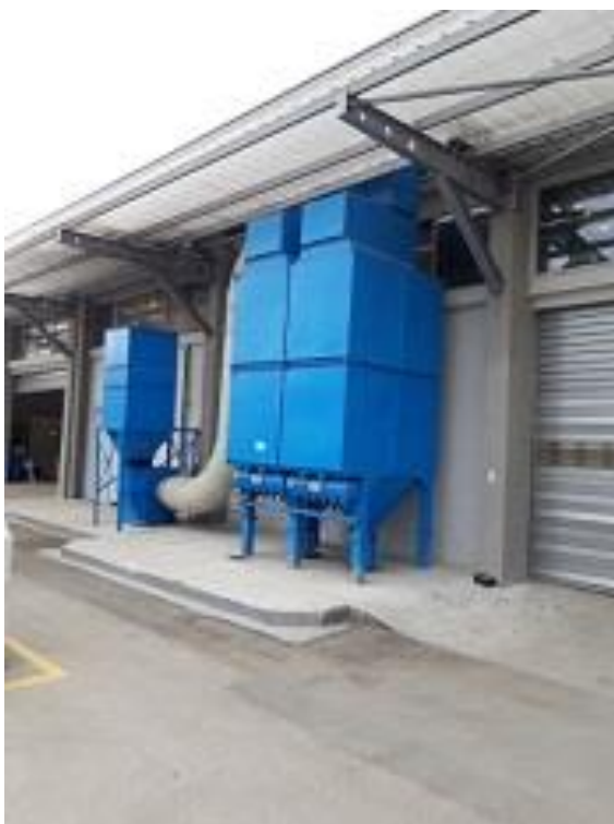
Φωτογραφία 15.8 & 15.9: Άποψη των συστημάτων επεξεργασίας αέρων ρύπων (συστήματα φίλτρων) της μονάδας.
