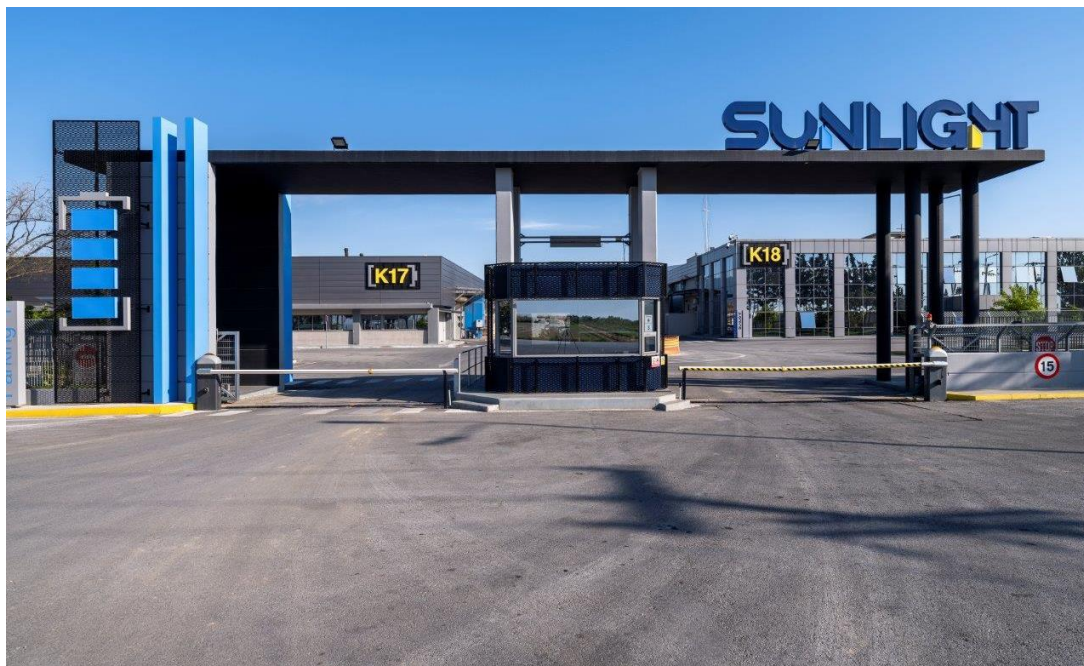
Φωτογραφία 15.5: Άποψη της εισόδου της μονάδας παραγωγής συσσωρευτών της εταιρείας SUNLIGHT GROUP ΣΥΣΤΗΜΑΤΑ ΑΠΟΘΗΚΕΥΣΗΣ ΕΝΕΡΓΕΙΑΣ, από νότια – νοτιοδυτικά.
