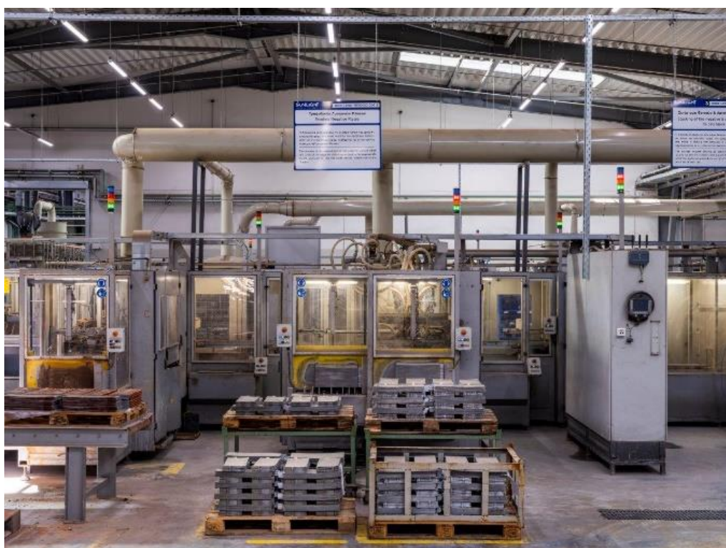
Φωτογραφία 15.11: Άποψη γραμμής τροφοδοσίας αρνητικών πλακών
