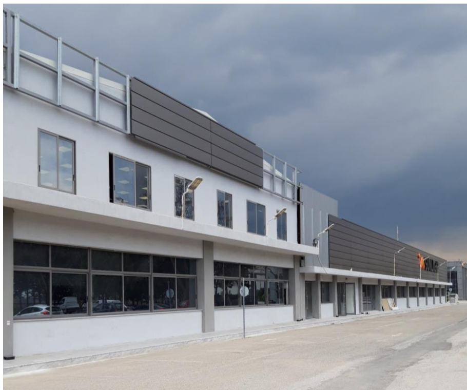
Φωτογραφία 15.7: Άποψη του κτιρίου παραγωγής συσσωρευτών βιομηχανικού τύπου και VRLA (K2).
