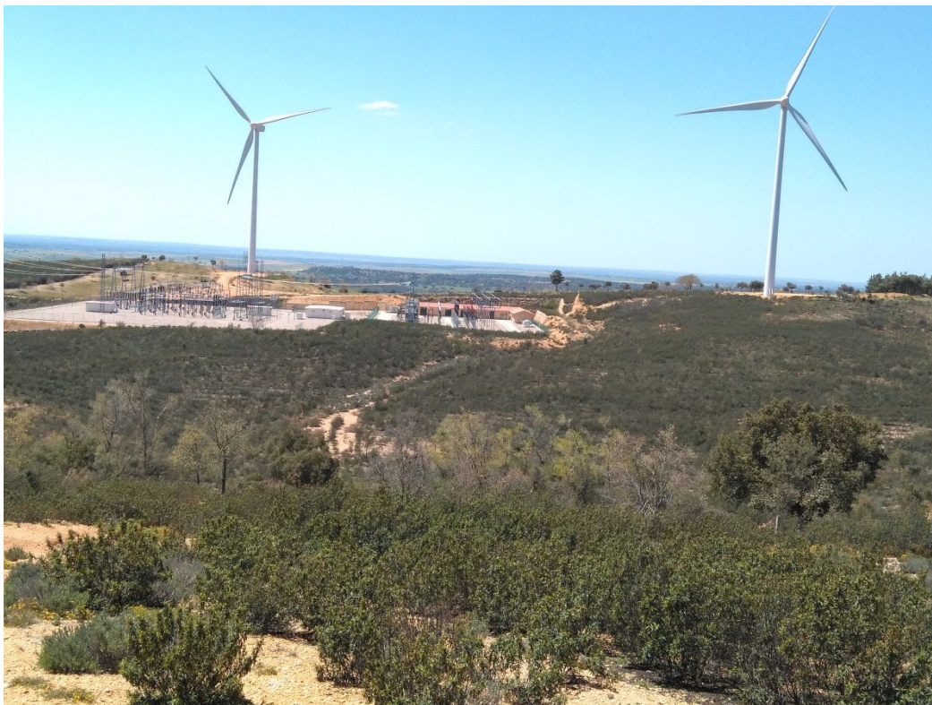
Vista de la subestación eléctrica de Santiz, donde enlazará la línea de evacuación de la planta Lerapa-Valdelosa I.
