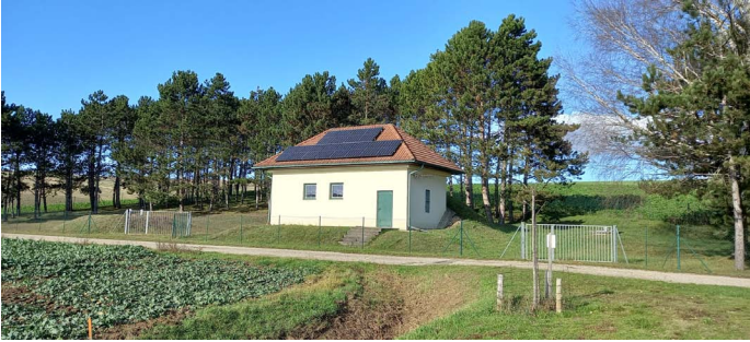
Schalthaus mit PV-Anlage
