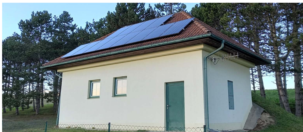
PV-Anlage am Brunnengebäude
