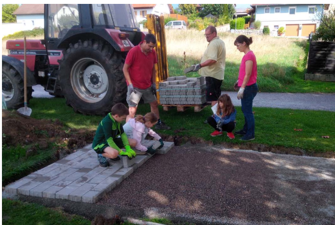
Pflastern beim neuen Tischtennistisch
