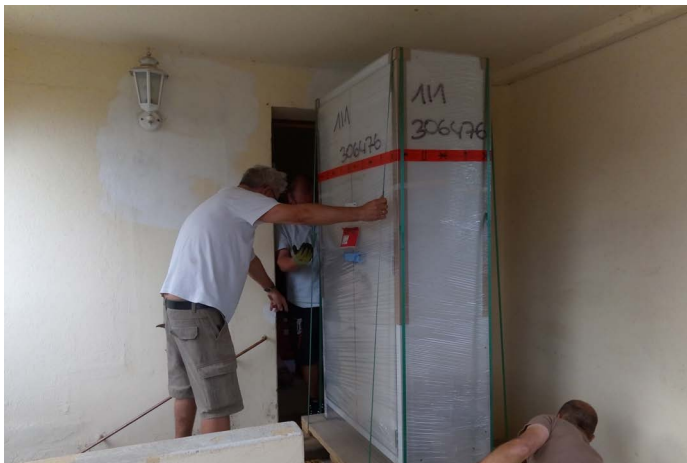
Millimeterarbeit beim Aufstellen des feuerfesten Schrankes
