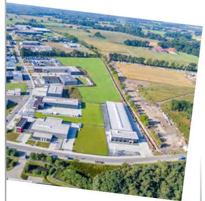
Die Erweiterungsflächen im Industriegebiet Süd-West
