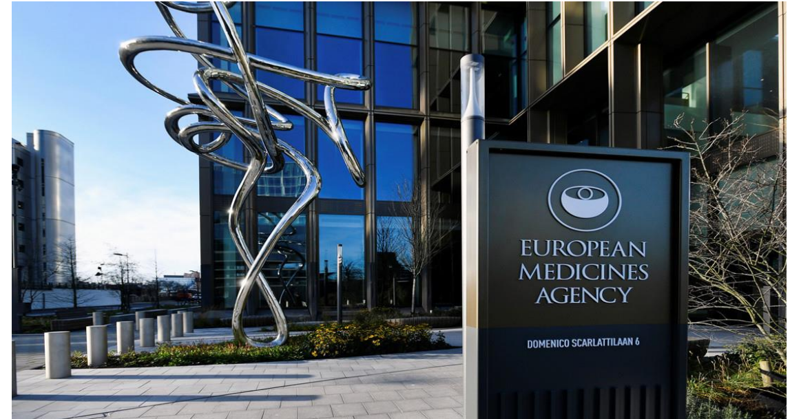
Fig.3. Edificio de la Agencia Europea de Medicamentos (EMA), Ámsterdam, Países Bajos. Fuente: Piroshka van de Wouw / Reuters.
