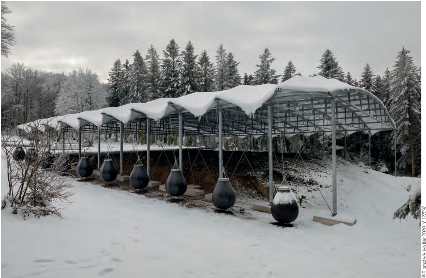
Abri de fouille dépourvu de fondations installé en 2020 sur le site d'une maison romaine de Bibracte, fruit d'une expérimentation menée avec l'architecte Paul Andreu (†) et l'agence d'ingénierie T/E/S/S.
