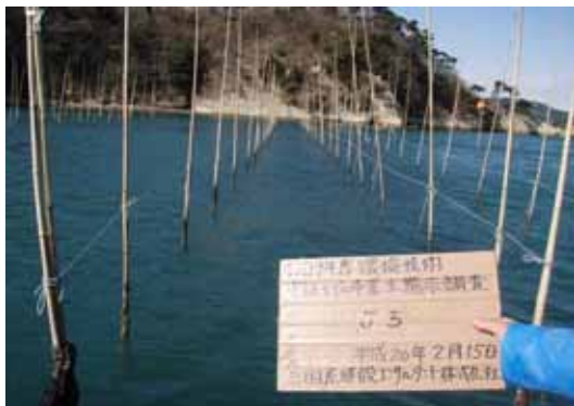
実証施設（J3）岸側方向を望む
