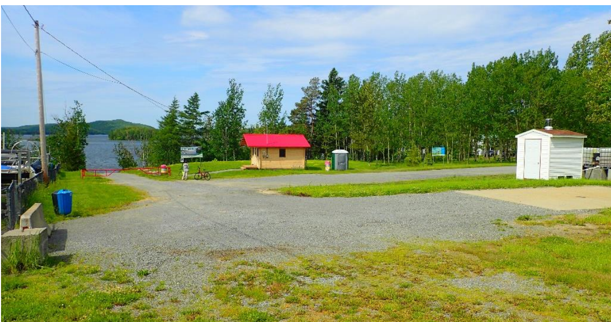
Station de Saint-Mathieu-de-Rioux, Bas-Saint-Laurent, située à bonne distance du lac et sur terrain plat. Outre la plateforme de nettoyage (à droite), elle est équipée d'un poste d'accueil pour le préposé (au centre). La rampe de mise à l'eau (à gauche) est fermée par une barrière en l'absence du préposé.
