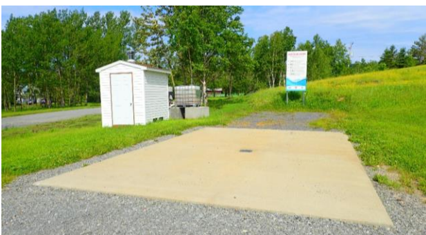
Plateforme de nettoyage avec son système d'eau à haute pression et son panneau d'instructions.
