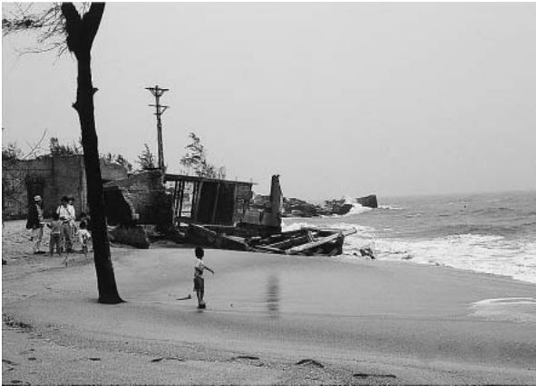
写真 1. ホアデュン湖口北西側の海岸浸食によって倒壊した民家 (2000 年 3 月 9 日撮影)
