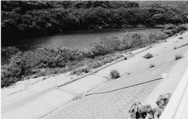
(1) ボーリング地点の堤防から対岸を眺める。急峻な谷地形を埋めて厚さ50~70mの砂礫層が分布する。
