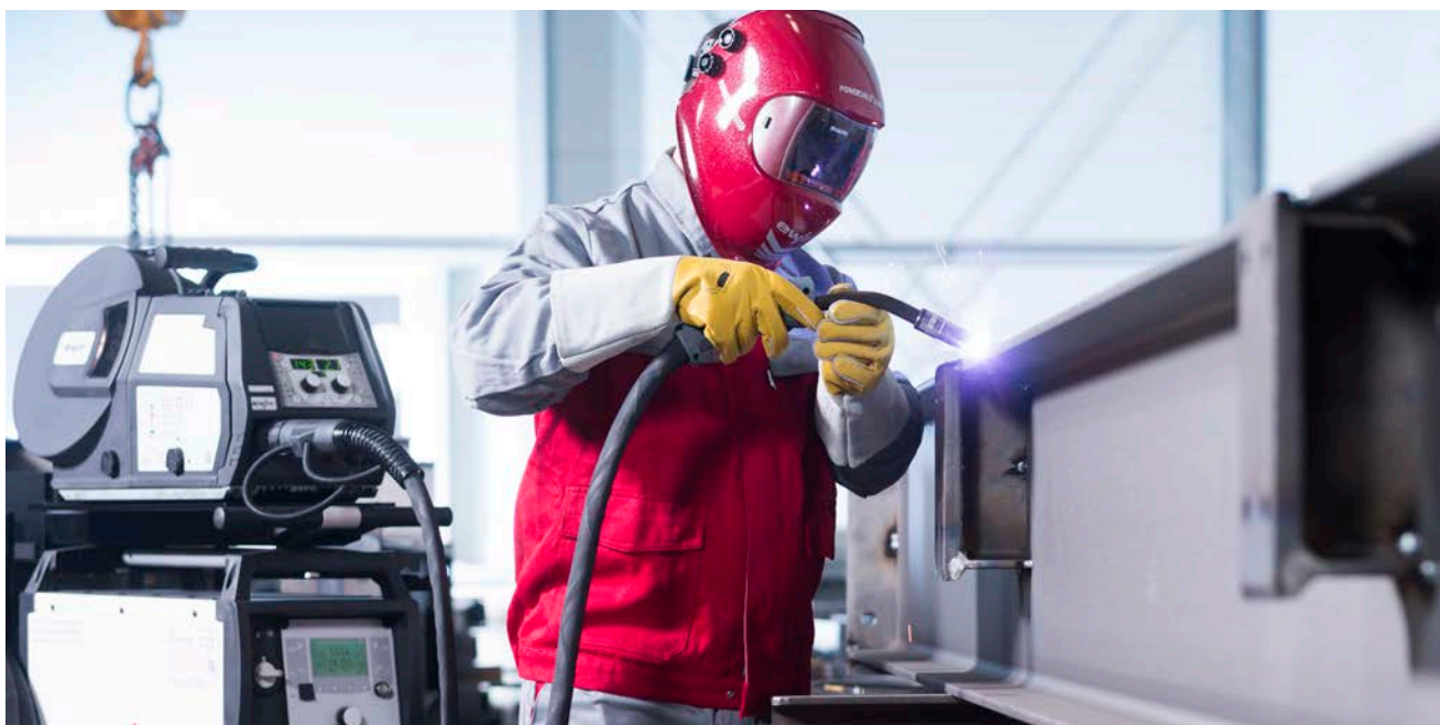
Bild 41: MAG-Schweißen im Stahlbau
