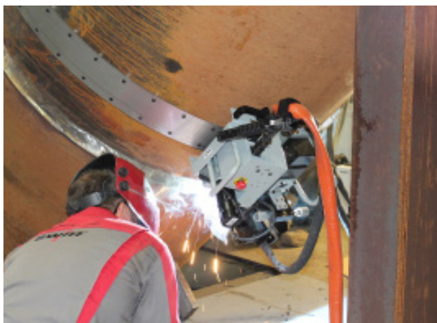
Bild 37: Vollmechanisches MSG-Orbitalschweißen
