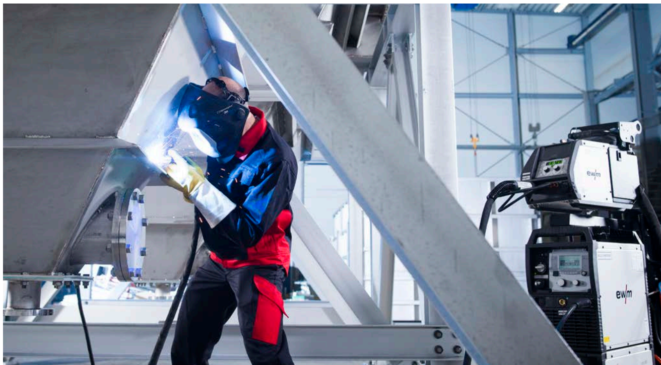
Bild 45: MAG-Schweißen eines Trichters aus CrNi-Stahl
