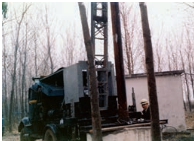
Εικ. 177. Εργαζόμενοι στον ΟΥΘ, κατά την επισκευή και συντήρηση των γεωτρήσεων κάπου στο Καλοχώρι, με το συμμαχικό αυτοκίνητο του Β΄ Παγκοσμίου Πολέμου, που το μετέτρεψαν σε γερανό για... ειρηνικούς σκοπούς (φωτ. Θ. Δάκος)
