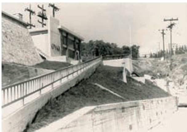
Εικ. 166. Το αντλιοστάσιο Ευαγγελίστριας, κατασκευής 1970, δίπλα στην παλιά δεξαμενή. Παίρνει νερό από το αντλιοστάσιο Δενδροποτάμου, και μέσω των αγωγών Φ800 και Φ500 στέλνει νερό στη δεξαμενή των 40 Εκκλησιών και στη νέα δίδυμη δεξαμενή της Ευαγγελίστριας. Η δεξαμενή αυτή υδροδοτεί το κέντρο, τη Διεθνή Έκθεση, και κάτω μέχρι την οδό Αγίας Τριάδος
