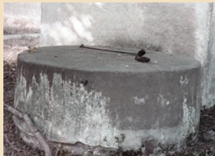
Εικ. 86. Χτιστό κάλυμμα αρτεσιανής γεώτρησης, ενώ φαίνεται και η μικρή θυρίδα, από όπου περνούσε ένα ξύλο 3-4 μ., που στο τέλος του είχε στερεωθεί ξύλινη, κωνική τάπα, για να βουλώσουν το στόμιο της γεώτρησης, όταν ήθελαν να διακόψουν την παροχή
