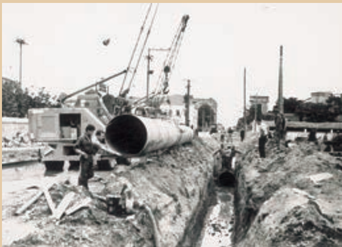
Εικ. 158. Εικόνες από την κατασκευή του αγωγού Φ1000 το 1968, που ξεκινούσε από το αντλιοστάσιο Δενδροποτάμου, συνέχιζε στην πλατεία Δημοκρατίας (Βαρδαρίου), μετά στο αντλιοστάσιο της οδού Κασσάνδρου, και νωρίτερα με διακλάδωση έδινε νερό και στη δεξαμενή της Καλλιθέας. Λειτουργεί και σήμερα (2017), και είναι ο πρώτος και μεγαλύτερος αγωγός υδροδότησης της πόλης
