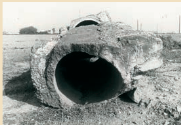
Εικ. 85. Το χτιστό υδραγωγείο της πρώτης εγκατάστασης, ελλειψοειδούς διατομής, όπως διακρίνεται, που το 1950 αντικαταστάθηκε από νεότερο, ορθογωνικής διατομής
