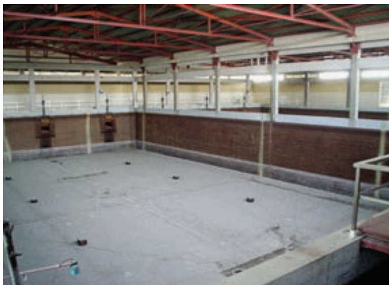
Εικ. 186. Το εσωτερικό της δεξαμενής καθιζήσεως άδειο
