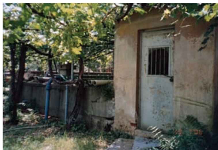
Εικ. 129. Η δεξαμενή (πάνω) και το αντλιοστάσιο Τούμπας (κάτω), όπως είναι σήμερα (2017), που χρησιμοποιούνται από το Συνεργείο Δικτύου Ανατολικού Τομέα της Διεύθυνσης Δικτύων Ύδρευσης. Το αντλιοστάσιο κατασκευάστηκε στη δεκαετία του 1920 και λειτούργησε μέχρι το 1960 περίπου. Ήταν ένα από τα περιφερειακά αντλιοστάσια, όπως τα ονόμαζαν στη δεκαετία του 1950
