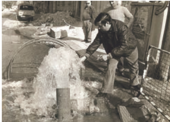
Εικ. 284. Ο συγγραφέας παίρνει δείγμα νερού από νεοτοποθετημένο αγωγό για τον έλεγχο της καθαρότητάς του. Η δειγματοληψία πρέπει να γίνει από εκκένωση της ίδιας διαμέτρου με τον καθαριζόμενο αγωγό και υπό συνθήκες λειτουργίας, για να έχουμε αντιπροσωπευτικό δείγμα και σωστό έλεγχο
