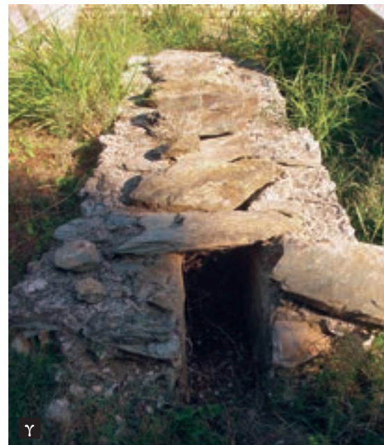
Εικ. 43. Ο κεντρικός αγωγός μεταφοράς του νερού των πηγών του Λεμπέτ, όπως αποκαλύφτηκε στην Παναγία Φανερωμένη (α) κατά την ανέγερση οικοδομής, και στην οδό Λαγκαδά στη Σταυρούπολη (β & γ), έξω από το σταθμό της ΔΕΗ, πλάτους 20 εκ. και ύψους 30 εκ.
