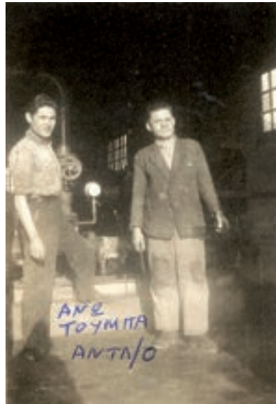
Εικ. 171. Εργαζόμενοι στο περιφερειακό αντλιοστάσιο Άνω Τούμπας το 1953, όπως το αναφέρει ο συνάδελφος Θ. Δάκος, που μου παραχώρησε τη φωτογραφία
