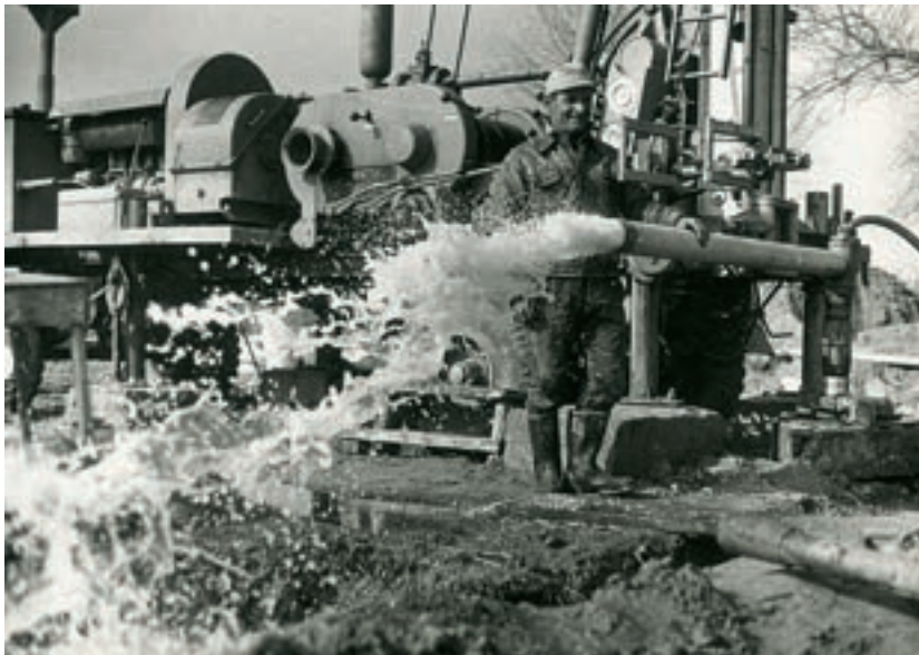
Εικ. 122. Δοκιμαστική λειτουργία γεώτρησης το 1960, που μόλις έχει ανορυχθεί
