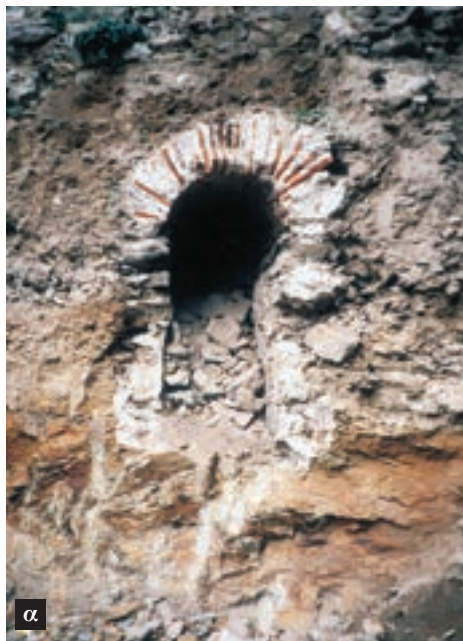
Εικ. 43. Ο κεντρικός αγωγός μεταφοράς του νερού των πηγών του Λεμπέτ, όπως αποκαλύφτηκε στην Παναγία Φανερωμένη (α) κατά την ανέγερση οικοδομής, και στην οδό Λαγκαδά στη Σταυρούπολη (β & γ), έξω από το σταθμό της ΔΕΗ, πλάτους 20 εκ. και ύψους 30 εκ.
