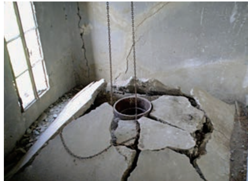
Εικ. 182. Ανυψωμένη γεώτρηση στο Καλοχώρι, λόγω καθίζησης του εδάφους από την εξαντλητική άντληση
