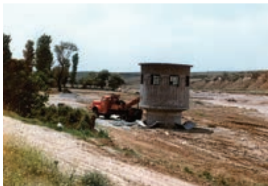
Εικ. 192. Εικόνα από την κατασκευή φρέατος (πηγαδιού) στην κοίτη του Γαλλικού ποταμού
