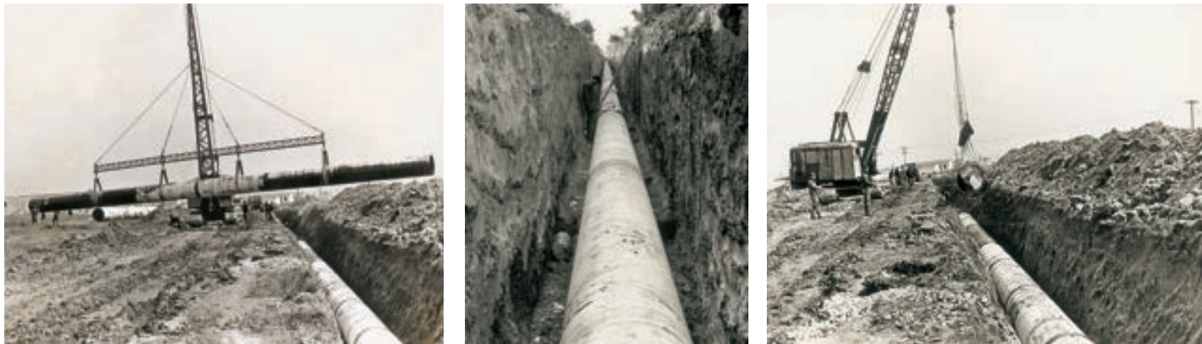
Εικ. 194. Εικόνες από την κατασκευή του αγωγού Φ1100 (Νάρρες - Διαβατά, 1968)
