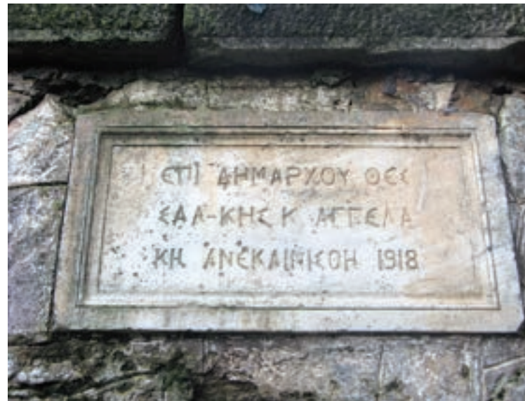
Εικ. 18. Η μαρμάρινη πλάκα που εντοιχίστηκε στο συγκεντρωτικό φρεάτιο των πηγών του Χορτιάτη το 1918, όταν έγινε η μεγάλη ανακαίνιση των πηγών και του υδραγωγείου, επί δημαρχίας Κωνσταντίνου Αγγελάκη
