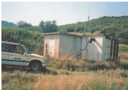
Εικ. 191. Το συγκεντρωτικό φρέατιο των γεωτρήσεων N8, N9 και N10, όπου γίνεται η προχλωρίωση του νερού της υδροληψίας Νάρρες
