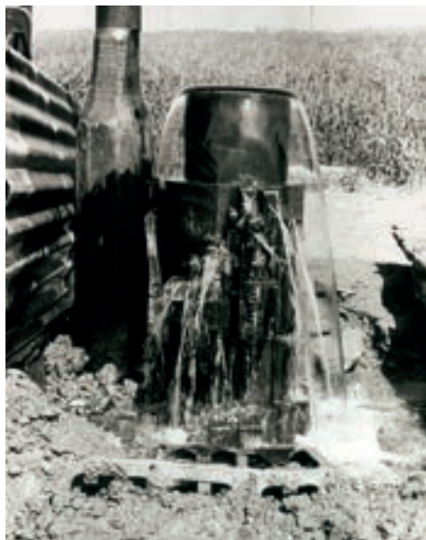
Εικ. 124. Αρτεσιανή γεώτρηση σε λειτουργία
