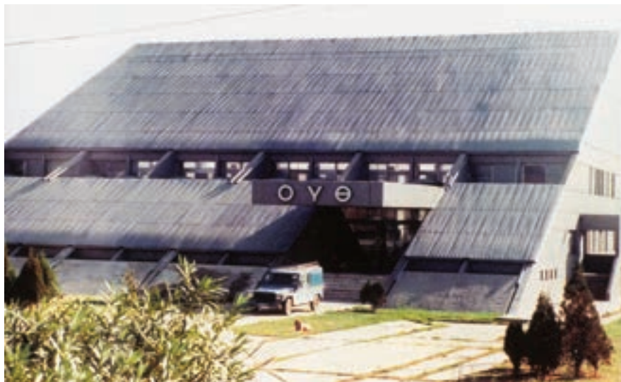
Εικ. 276. Το αντλιοστάσιο Δενδροποτάμου, που για πρώτη φορά λειτούργησε τον Ιούλιο του 1978
