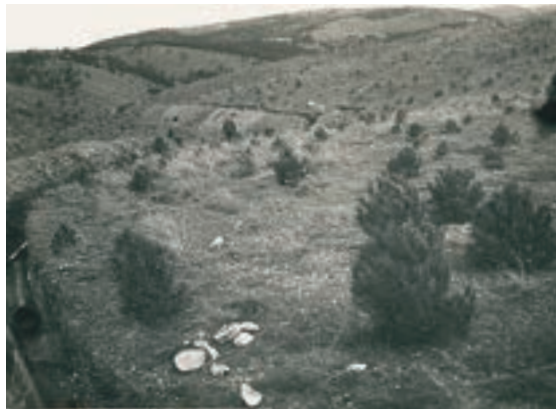
Εικ. 37. Εικόνες από τη σωλήνωση του υδραγωγείου το 1950 (φωτ. Μιχ. Κεραμιδάς)
