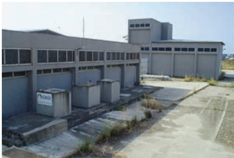
Εικ. 184. Η δεξαμενή καθιζήσεως εξωτερικά
