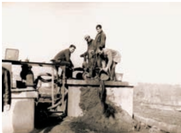
Εικ. 183. Εικόνες από τον καθαρισμό του υδραγωγείου Καλοχωρίου το 1968, όταν είχε γεμίσει με άμμο και σιδηροβακτηρίδια
