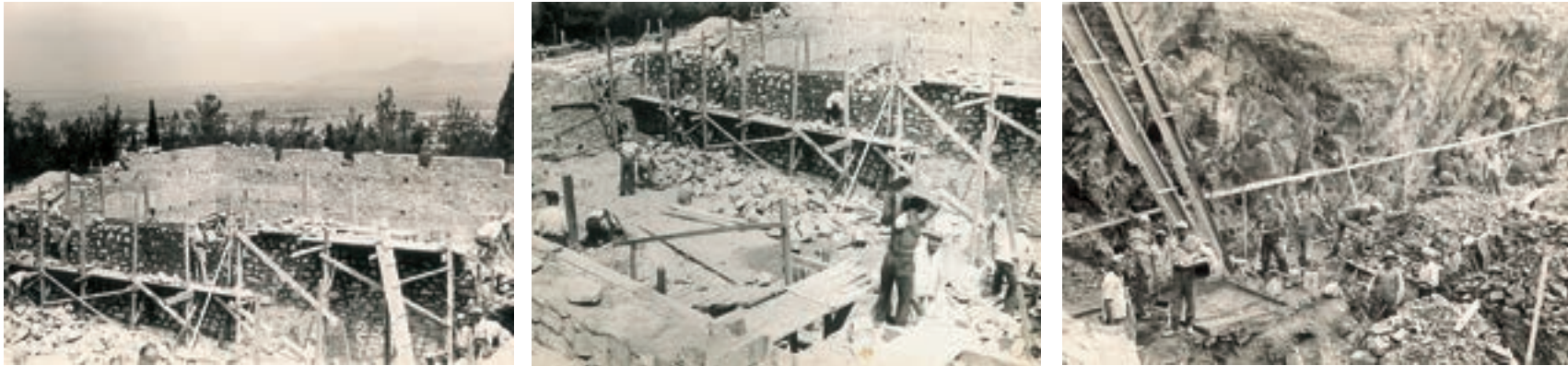
Εικ. 162. Εικόνες από την κατασκευή της δεξαμενής των 40 Εκκλησιών μέσα στο δάσος, πάνω από το συνοικισμό, το 1955-56. Η δεξαμενή, που λειτουργεί και σήμερα, παίρνει νερό από το αντλιοστάσιο της δεξαμενής Ευαγγελίστριας, και υδροδοτεί το συνοικισμό των 40 Εκκλησιών και τα υψηλά σημεία της Άνω Τούμπας (Κρουονέρι)
