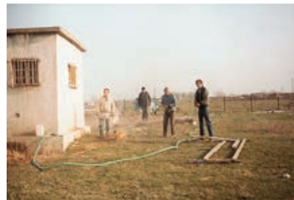
Εικ. 189. Συνεργείο απολυμάνσεων του ΟΥΘ εφαρμόζει πρόγραμμα υπερχλωρίωσης της γεώτρησης Σ26 για τη βελτίωση του αντλούμενου νερού, με τη φθορά των σιδηροβακτηριδίων (1980)
