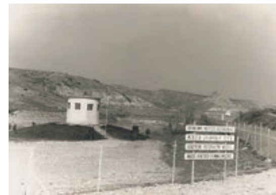
Εικ. 193. Πηγάδι στην κοίτη του Γαλλικού στο Νάρρες
