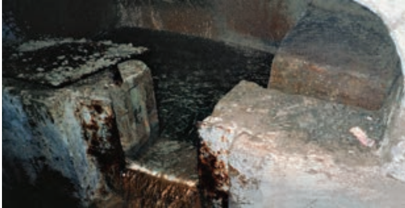
Εικ. 120. Το εσωτερικό των πηγών του Χορτιάτη
