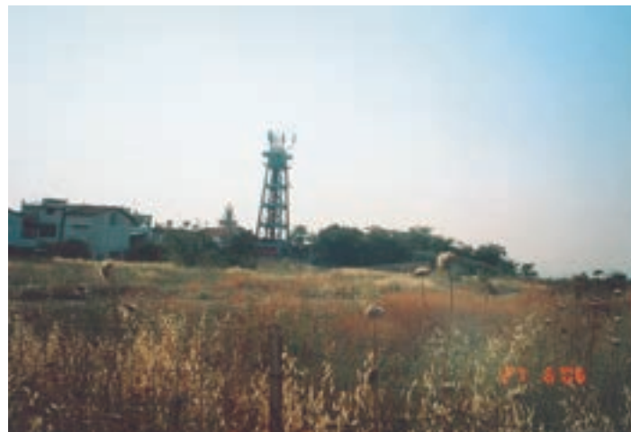
Εικ. 244. Ο υδατόπυργος στην κορυφή του λόφου στην Αγία Κυριακή Χαριλάου, που σήμερα χρησιμοποιείται ως βάση κεραιών κινητής τηλεφωνίας
