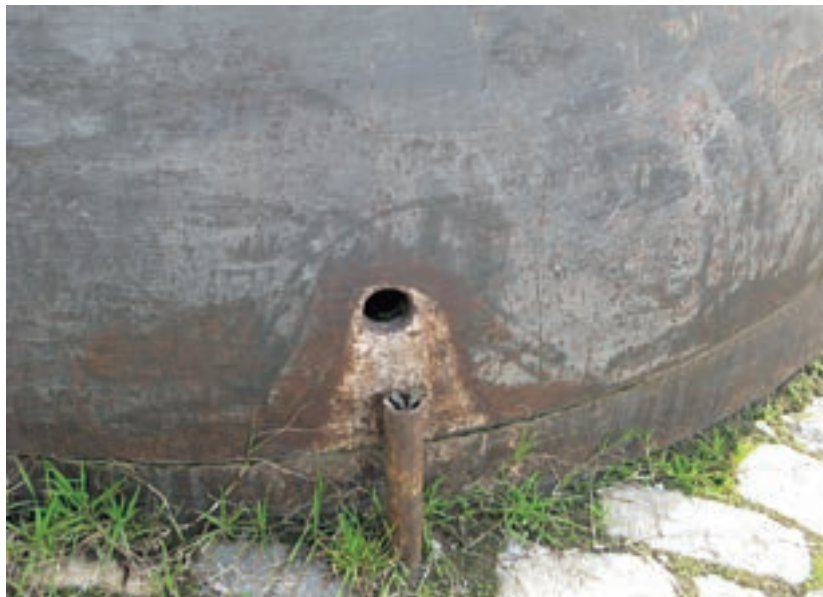
Εικ. 274. Το σημείο εισαγωγής του υποχλωριώδους ασβεστίου στο φρεάτιο του Κ.Α.Σ. για την απολύμανση του νερού
