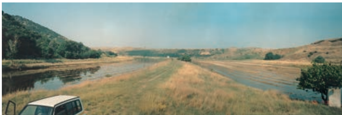
Εικ. 190. Η διαμορφωμένη κοίτη του Γαλλικού ποταμού στη θέση Νάρρες
