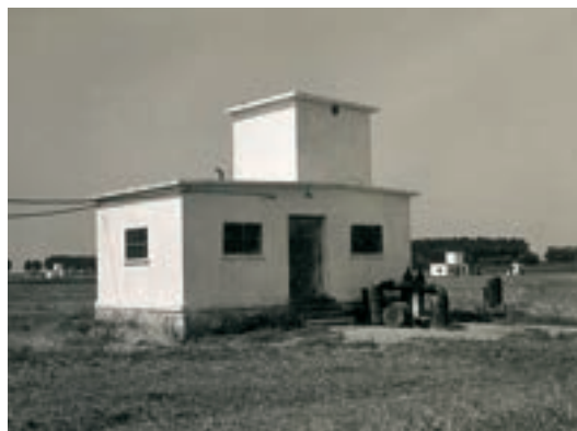
Εικ. 179. Οικίσκος γεώτρησης Καλοχωρίου. Τα βαρέλια που διακρίνονται προορίζονταν για τη μεταφορά του πετρελαίου των μηχανών που κινούσαν τη γεώτρηση (φωτ. Φ. Κουμπούλης)
