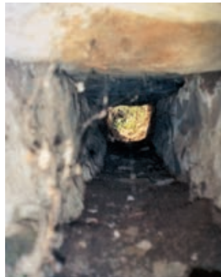
Εικ. 23. Το εσωτερικό του αγωγού του υδραγωγείου Χορτιάτη
