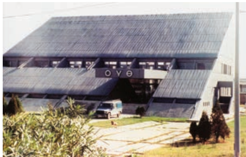
Εικ. 212. Το κεντρικό αντλιοστάσιο Δενδροποτάμου, που εγκαινιάστηκε το 1978 σε αντικατάσταση του Κ.Α.Σ.
