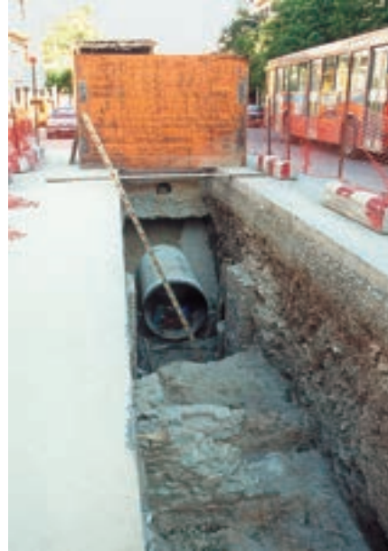
Εικ. 261. Εικόνες από την εκσκαφή στην οδό Αγίου Δημητρίου, για την τοποθέτηση του σιδερένιου αγωγού Φ1100, που έφερε το νερό από την ΕΕΝ μέχρι τη δεξαμενή Τούμπας (Κρουονερίου)
