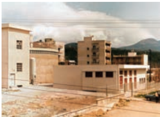
Εικ. 165. Η τρίδυμη δεξαμενή με το αντλιοστάσιο Τούμπας (Κρουονερίου), κατασκευής του 1974. Παίρνει νερό από το αντλιοστάσιο Κασσάνδρου και υδροδοτεί την ανατολική Θεσσαλονίκη (Τούμπα, Χαριλάου, Καλαμαριά, Πανόραμα κ.τ.λ.). Τροφοδοτεί επίσης με νερό και τις δύο δεξαμενές Κόστα Μπόδα και Ουτσάρσο μέσα στο δάσος του Σέιχ Σου για πυρόσβεση. Είναι η μεγαλύτερη δεξαμενή και σήμερα παίρνει νερό και από το διωλιστήριο του Αλιάκμονα
