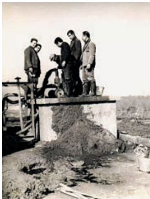
Εικ. 183. Εικόνες από τον καθαρισμό του υδραγωγείου Καλοχωρίου το 1968, όταν είχε γεμίσει με άμμο και σιδηροβακτηρίδια
