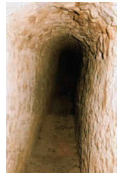
Εικ. 32. Η υδρομαστευτική στοά στην πάνω πηγή του Ρετζικίου
