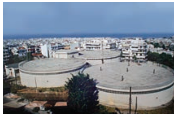
Εικ. 165. Η τρίδυμη δεξαμενή με το αντλιοστάσιο Τούμπας (Κρουονερίου), κατασκευής του 1974. Παίρνει νερό από το αντλιοστάσιο Κασσάνδρου και υδροδοτεί την ανατολική Θεσσαλονίκη (Τούμπα, Χαριλάου, Καλαμαριά, Πανόραμα κ.τ.λ.). Τροφοδοτεί επίσης με νερό και τις δύο δεξαμενές Κόστα Μπόδα και Ουτσάρσο μέσα στο δάσος του Σέιχ Σου για πυρόσβεση. Είναι η μεγαλύτερη δεξαμενή και σήμερα παίρνει νερό και από το διωλιστήριο του Αλιάκμονα
