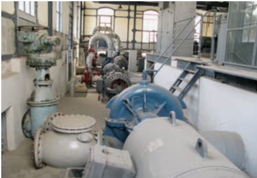
Εικ. 229. Οι ηλεκτροκίνητες αντλίες του Κ.Α.Σ., μετά από την αποκατάσταση
