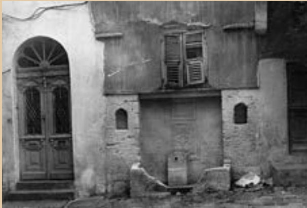
Εικ. 53. Οθωμανική κοινόχρηστη βρύση στην οδό Ολυμπιάδος. Η βρύση διατηρείται ενώ το κτήριο έχει καταφιστεί
