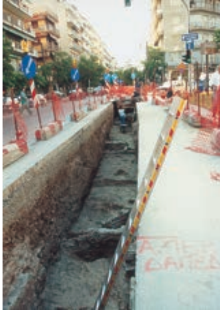
Εικ. 261. Εικόνες από την εκσκαφή στην οδό Αγίου Δημητρίου, για την τοποθέτηση του σιδερένιου αγωγού Φ1100, που έφερε το νερό από την ΕΕΝ μέχρι τη δεξαμενή Τούμπας (Κρουονερίου)
