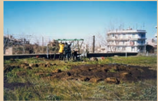
Εικ. 217. Συνεργείο της ΕΥΑΘ κατά τον καθαρισμό της δεξαμενής Καλλιθέας το 2000
