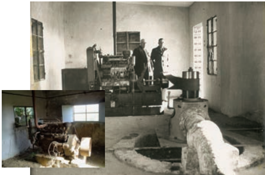
Εικ. 181. Το εσωτερικό ενός αντλιοστασίου (γεώτρησης) στο Καλοχώρι, εξοπλισμένου με την πετρελαιομηχανή μάρκας Pelarone, που λειτουργούσε τη δεκαετία του 1950 για κίνηση με λουρί της αντλίας βαθέων φρεάτων τύπου πομόνας
