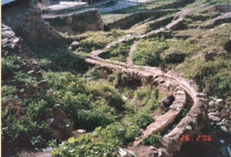
Εικ. 44. Διακλάδωση διανομής νερού έξω από τη δεξαμενή των Δώδεκα Αποστόλων, στα δυτικά της πόλης
