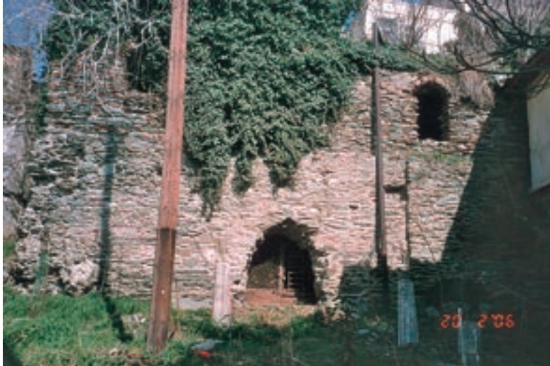
Εικ. 68. Βυζαντινή δεξαμενή στην Άνω Πόλη (οδός Βλατάδων), που έπαιρνε νερό από το υδραγωγείο του Χορτιάτη
