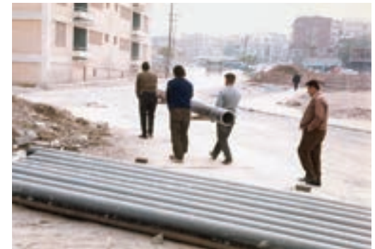
Εικ. 176. Εικόνες από εργαζόμενους στον ΟΥΘ, την περίοδο 1950-1960, κατά την τοποθέτηση αγωγών μέσα στην πόλη, χωρίς βοήθεια από εργολάβους ή μηχανήματα. Μόνο με ψυχή και σώμα... Έτσι στήθηκε η ύδρευση της Θεσσαλονίκης!
