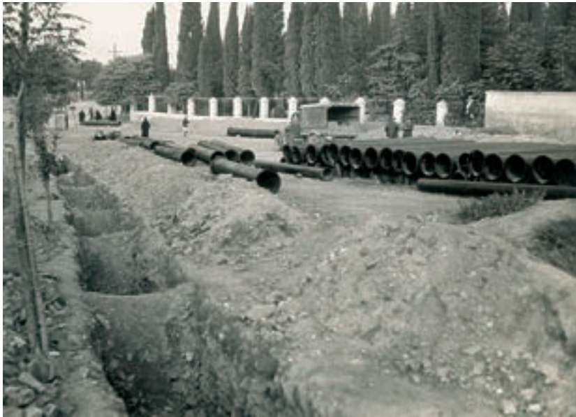
Εικ. 155. Τοποθέτηση του μαντεμένιου αγωγού Φ600 το 1956, για την τροφοδοσία της δεξαμενής Ευαγγελιστρίας από το Κ.Α.Σ.
