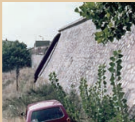
Εικ. 216. Εικόνες από την εξωτερική κατασκευή της δεξαμενής Ευαγγελίστριας, που είναι εξ ολοκλήρου πετρόκτιστη (1911)
