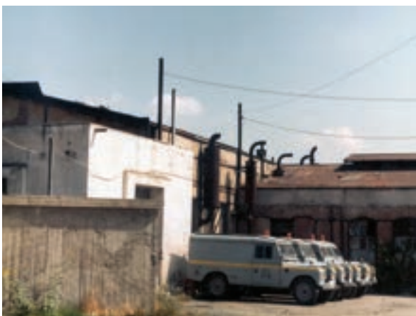
Εικ 225. Το κτίσμα που προστέθηκε το 1942 για τις εγκαταστάσεις πτωχού αερίου, την εποχή της κατασκευής του (πάνω) και αργότερα, το 1980 (κάτω)
