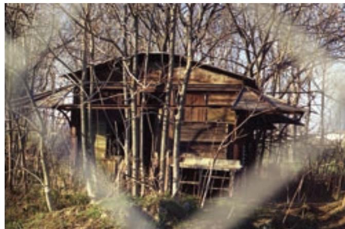
Εικ. 82. Μεταλλικός οικίσκος δίπλα από τις γεωτρήσεις, ίδιας κατασκευής με το κτήριο του Κ.Α.Σ. στο Καλοχώρι, που εχρησιμοποιούνταν ως συνεργείο επισκευών και φυλάκιο
