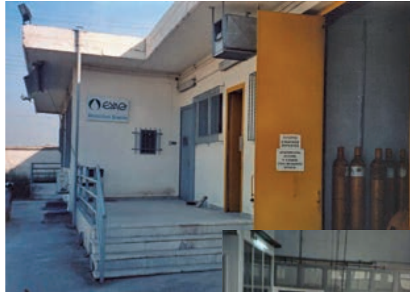
Εικ. 199. Το αντλιοστάσιο Διαβατών εξωτερικά
