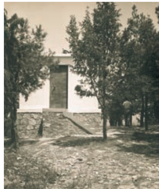
Εικ. 41. Ο οικίσκος στη δεξαμενή Συκεών (Δενδροφυτεία), όπου γινόταν η χλωρίωση του νερού των πηγών Ρετζικίου, που έφτανε εδώ με υδραγωγείο που σωληνώθηκε το 1950
