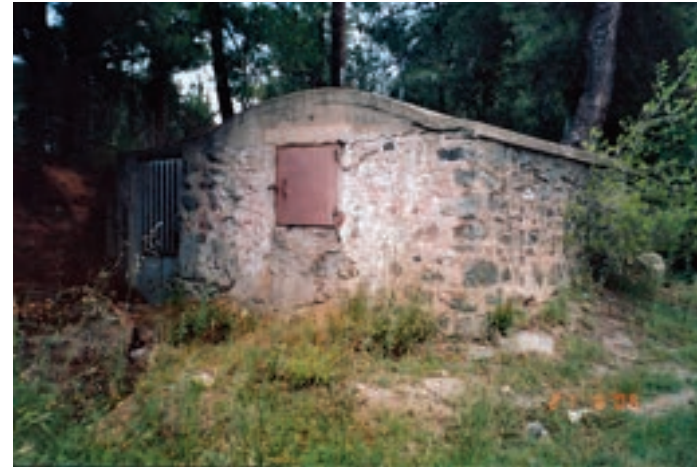
Εικ. 246. Το φρεάτιο 30 στο δρόμο προς Πανόραμα, στη διακλάδωση του δρόμου προς τον οικισμό Ν 751, ήταν πάνω στον κεντρικό αγωγό μεταφοράς του νερού των πηγών Χαριλάου από το Χορτιάτη. Η χρήση του ήταν και παραμένει η διανομή του νερού
