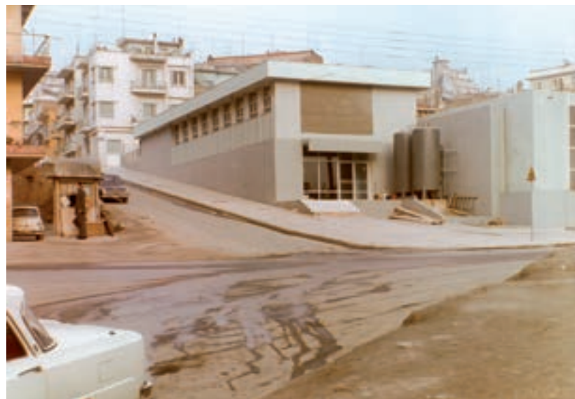
Εικ. 102. Η δεξαμενή και το αντλιοστάσιο Καλλιθέας
