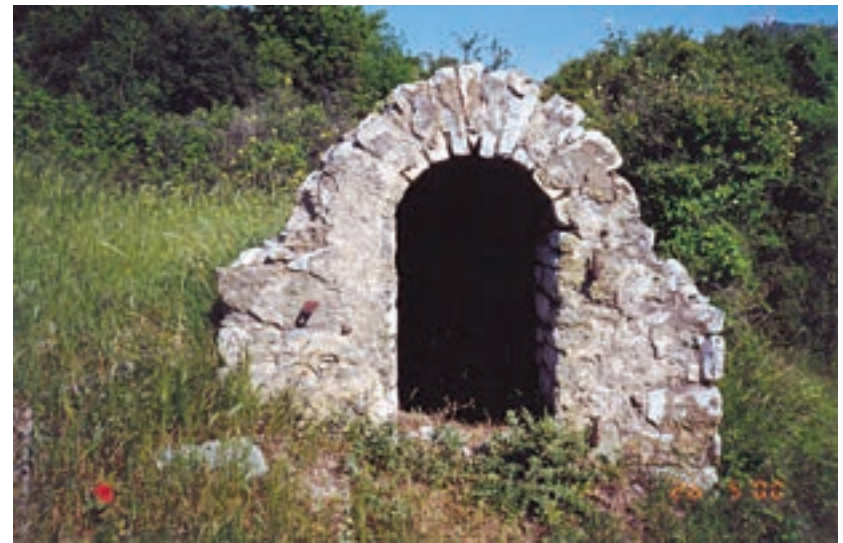
Εικ. 24. Χτιστό φρεάτιο που κάλυπτε διακλάδωση του υδραγωγείου, σημείο καθαρισμού ή φρεάτιο πτώσεως σε μεγάλη κλίση του εδάφους, δηλαδή ανέκοπτε την ορμή του νερού που θα προκαλούσε ζημιά στο υδραγωγείο
