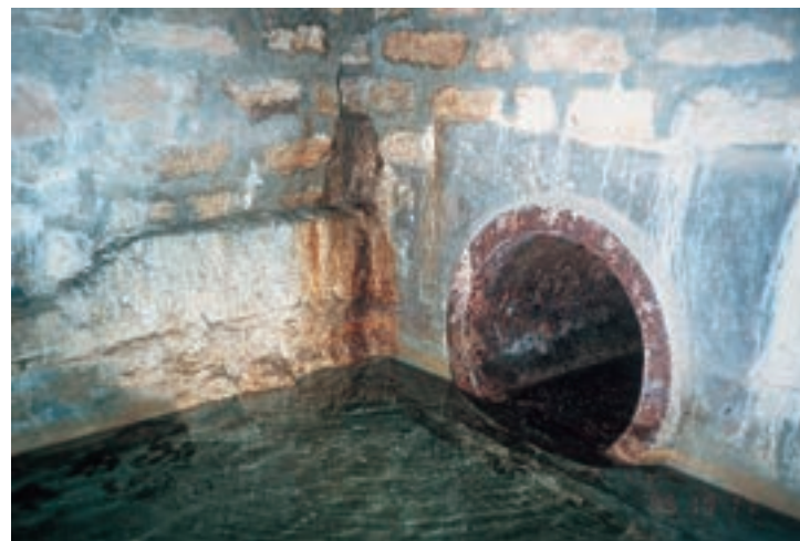
Εικ. 253. Ο αγωγός απαγωγής του νερού στην αρχή του υδραγωγείου Χαριλάου
