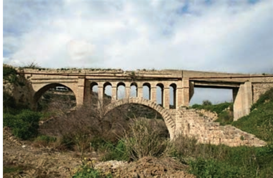
Εικ. 3. Υδατογέφυρα στην Κόρινθο
