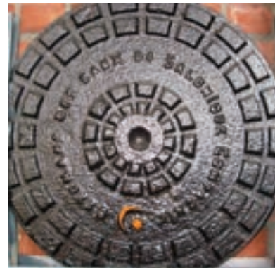
Εικ. 287. Καπάκι φρεατίου δικλίδων Φ800, από την πρώτη εγκατάσταση το 1890, το οποίο εκτίθεται στο μουσείο
