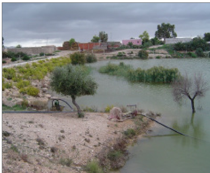
Figure 8: Captage des eaux de surface par une retenue collinaire
