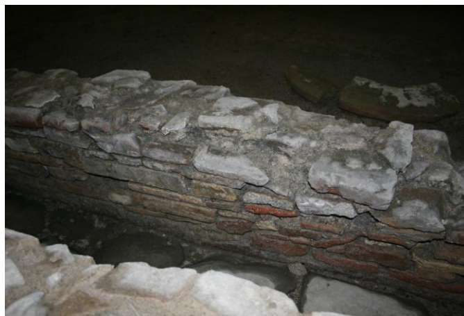
Fig. 23. Particolare delle spallette della canaletta, costruite in un primo momento fuori terra e poi sfruttate come contenimento della bonifica.
