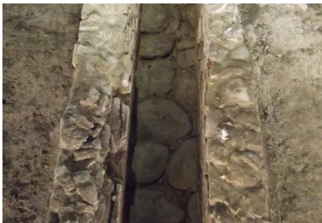
Fig. 22. Particolare del fondo in basoli della canaletta.
