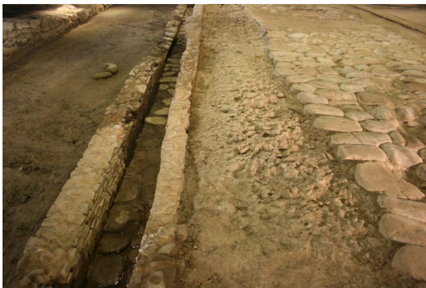
Fig. 25. Veduta generale della canaletta col fondo risparmiato e la nuova sede stradale, col marciapiede E di ridotte dimensioni.
